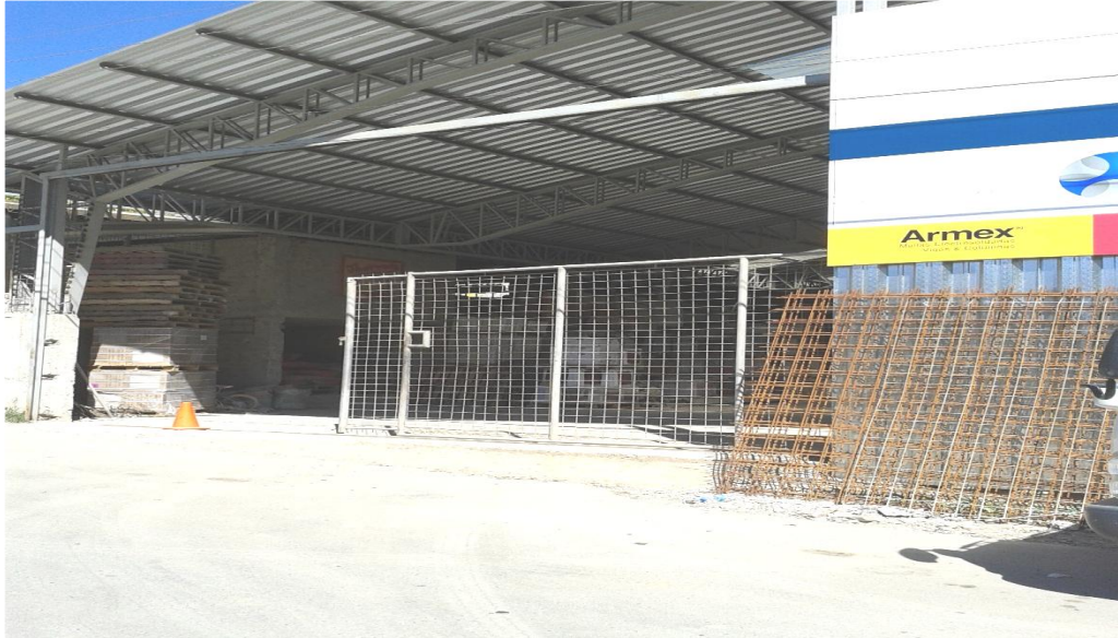
FOTO 3 BODEGA DE MATERIALES DE CONSTRUCCIÓN
