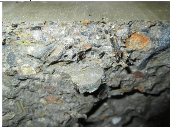
FOTOGRAFÍA 15.- Fibra en el hormigón
