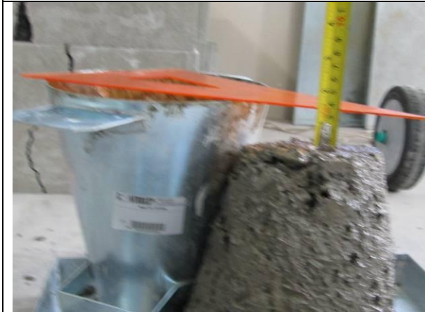
FOTOGRAFÍA 09.- Chequeo de la consistencia del hormigón
