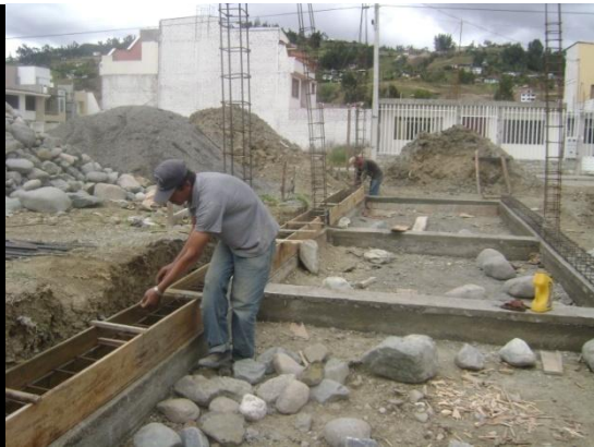
FOTO 4: Cimientos de hormigón ciclópeo
