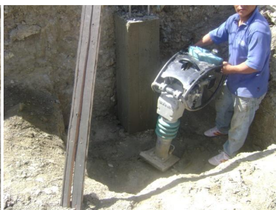
FOTO 36: Compactación con Vibroapisonador
