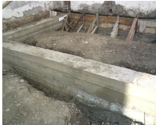
FOTO 10: Muros de Hormigón Ciclópeo
