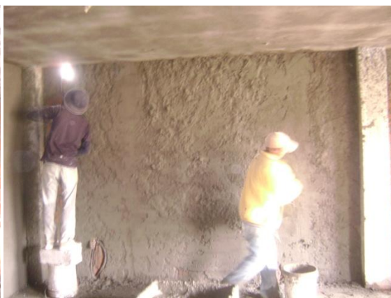
FOTO 20: Enlucido Vertical Pared
