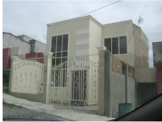
FOTO 6: Vivienda 2 plantas intervenida
