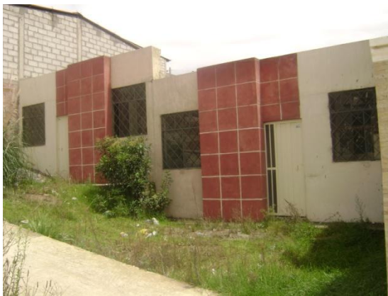
FOTO3: Viviendas 1 planta deshabitadas
