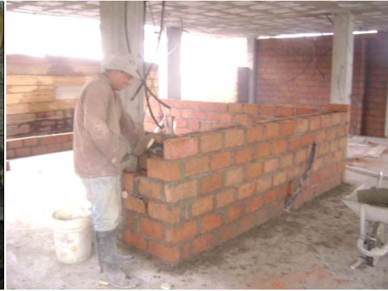
FOTO 14: Mampostería de Ladrillo
