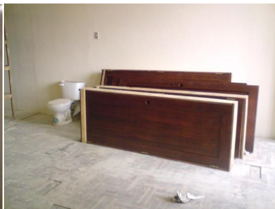
FOTO 24: Puertas de Madera
