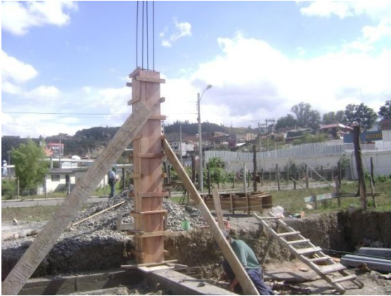
FOTO 37: Encofrado tradicional
