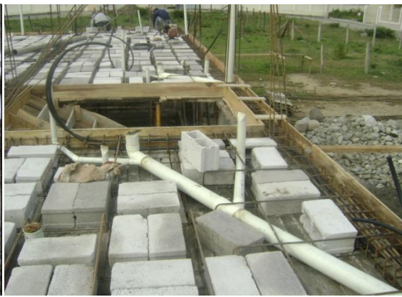
FOTO 16: Puntos de desagüe
