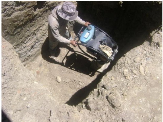
FOTO 3: Relleno a máquina con mejoramiento
