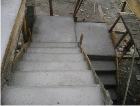
FOTO 13: Escalera de Hormigón
