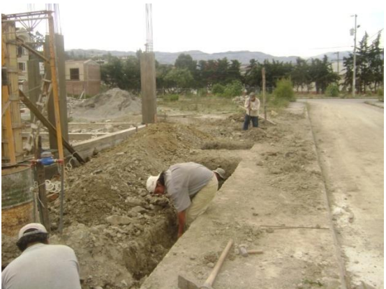
FOTO 41: Excavación tradicional manual
