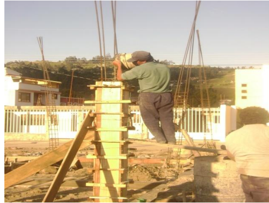
FOTO 8: Columnas de Hormigón Simple
