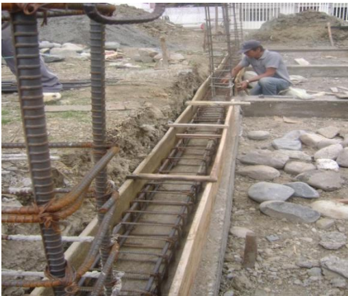
FOTO 9: Cadenas de Hormigón Simple
