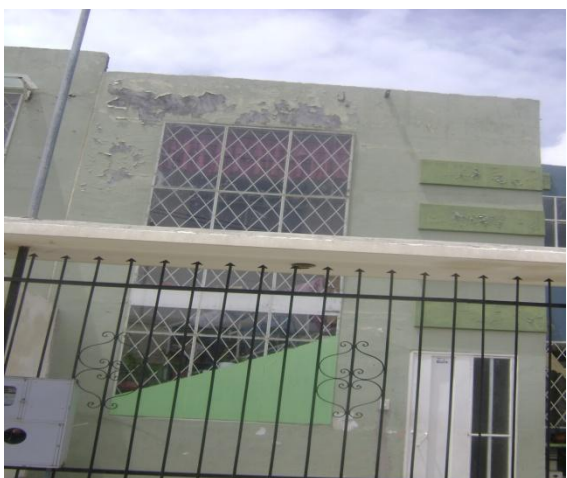
FOTO 15: Fallas en pintura exterior
