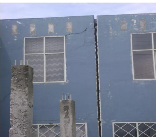
FOTO 16: Fallas en juntas, grietas pared
