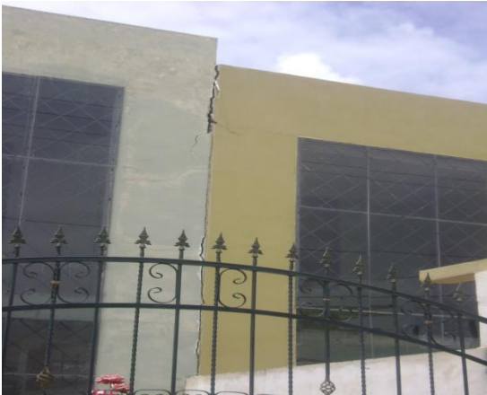
FOTO 13: Fallas en instalación eléctrica acometida FOTO 14: Fallas en juntas
