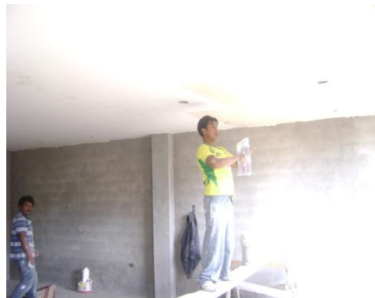
FOTO 28: Empaste Horizontal Losa Interior
