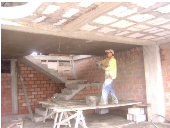
FOTO 19: Enlucido Horizontal Losa
