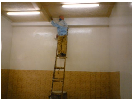
FOTO 23: Pintura Interior Pared
