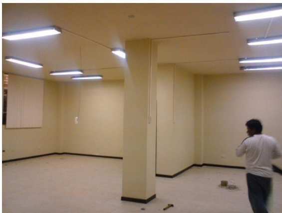
FOTO 29: Pintura Interior Pared
