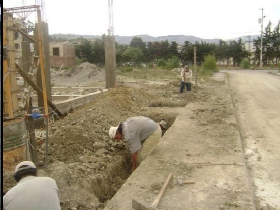
FOTO 2: Excavación manual en cimientos
