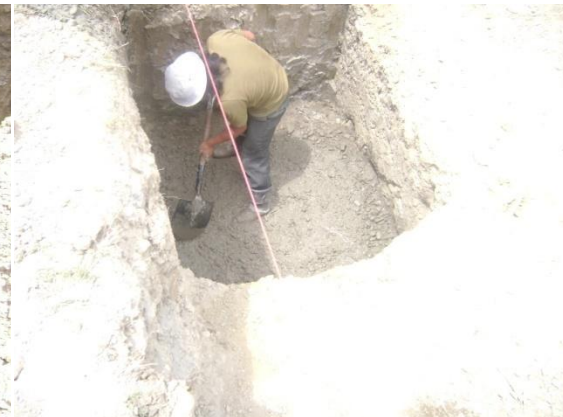
FOTO 6: Replanteo de H.S. en plintos
