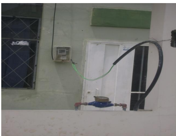
FOTO 13: Fallas en instalación eléctrica acometida FOTO 14: Fallas en juntas
