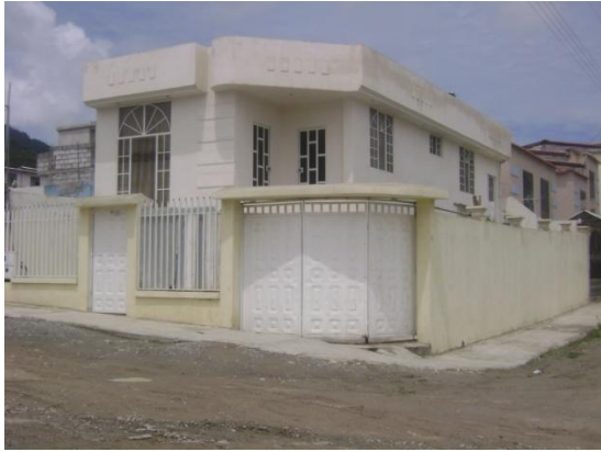
FOTO 5: Vivienda 1 planta intervenida
