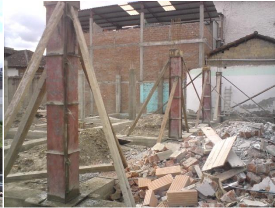
FOTO 38: Encofrado metálico
