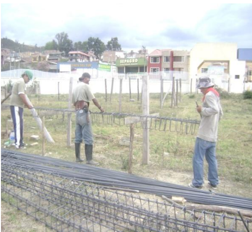
FOTO 11: Acero de Refuerzo
