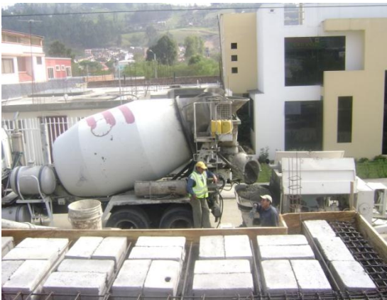
FOTO 40: Hormigón premezclado
