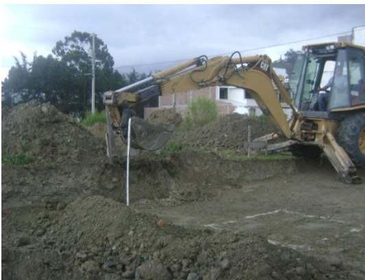
FOTO 42: Excavación con maquinaria
