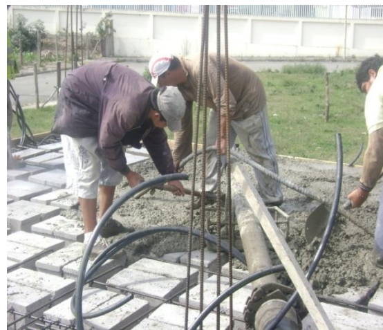
FOTO 12: Hormigón Simple en Losa
