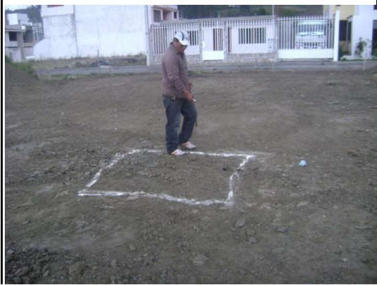
FOTO 1: Replanteo y Nivelación manual
