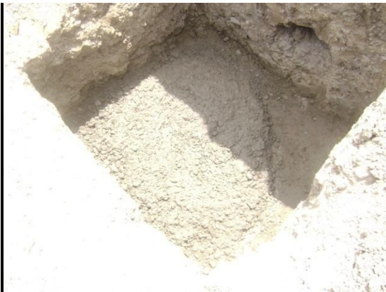
FOTO 5: Replanteo de H.S. en plintos
