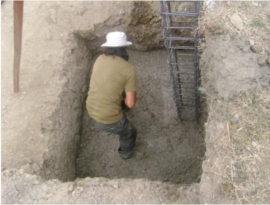
FOTO 7: Plintos de Hormigón Simple
