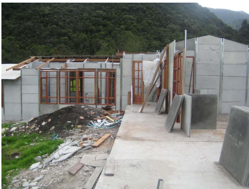
Armado y montaje de viviendas prefabricadas en Colombia
