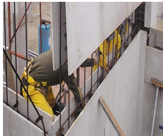
FIGURA 1.2. construcción de paredes de fibrocemento (fuente sitio web: www. plycem.com )
