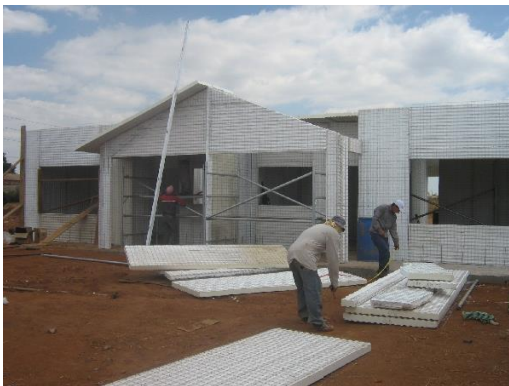
Armado y montaje de viviendas sistema Homi-2
