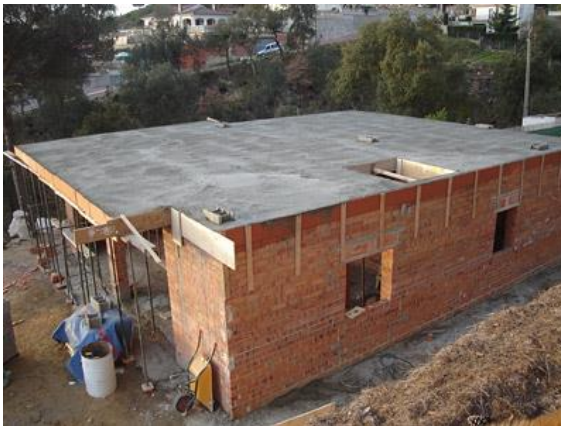
Pared de ladrillo cocido
