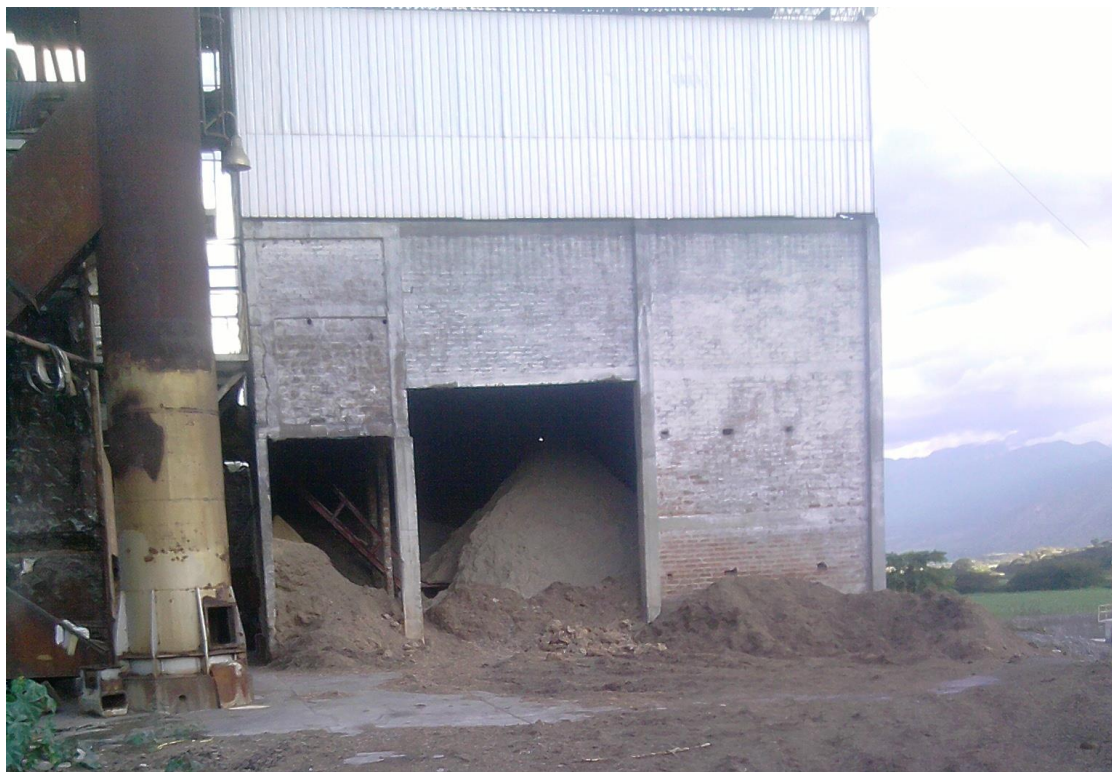
FIGURA 2.1. Depósito de bagazo de caña de azúcar – Ingenio Monterrey - Catamayo
