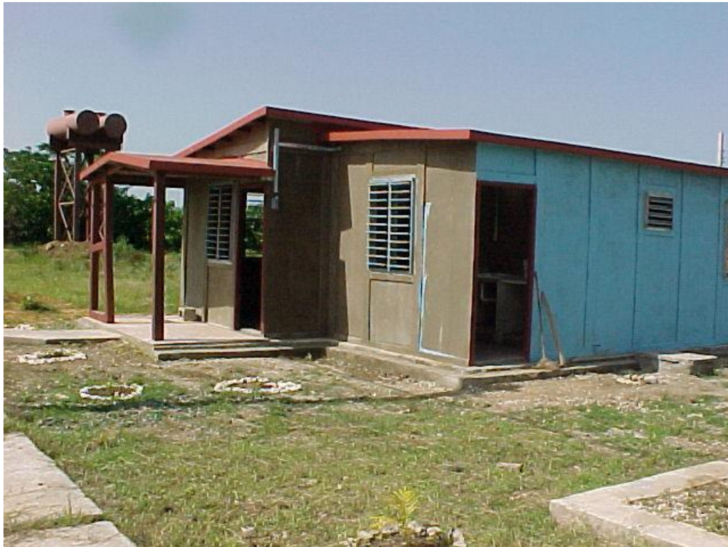
Vivienda de paneles de bagazo de caña de azúcar en Cuba
