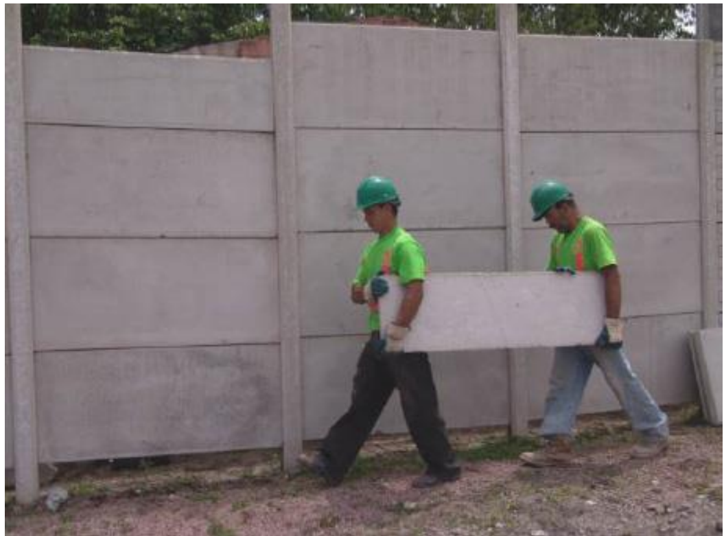
Armado y montaje de pared con paneles prefabricados en Costa Rica
