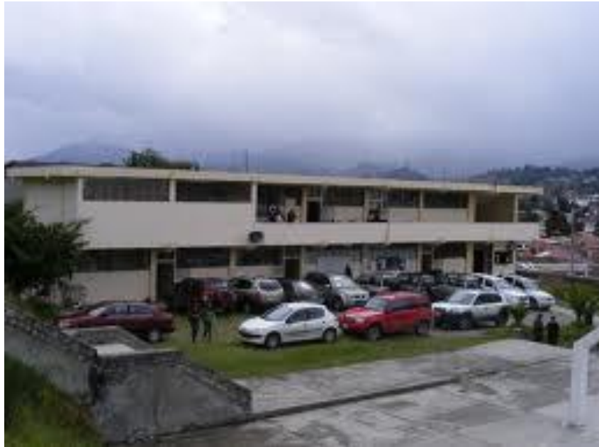
Fotografía 9: Vista Panorámica del Colegio Técnico "27 de Febrero"
