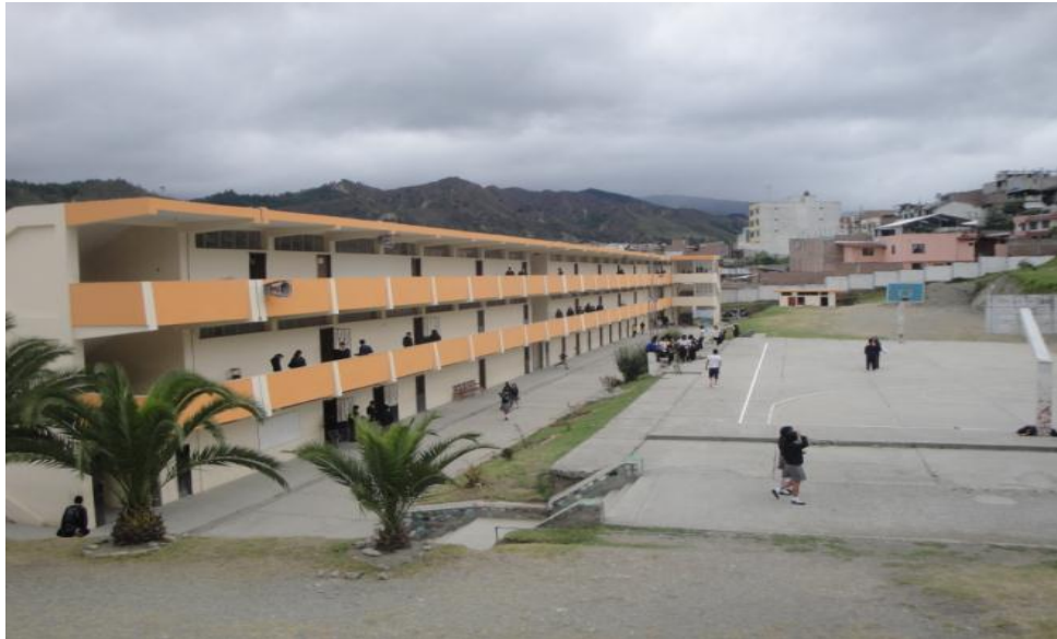
Fotografía 7: Vista Panorámica del Colegio Técnico “27 de Febrero”
