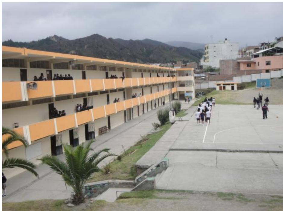
Fotografía 8: Vista Panorámica del Colegio Técnico “27 de Febrero”
