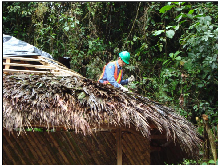
Figura 11. Colocación de hoja de palma en el techo del centro de visitantes
