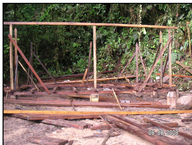
Figura 10. Construcción del centro de visitantes
