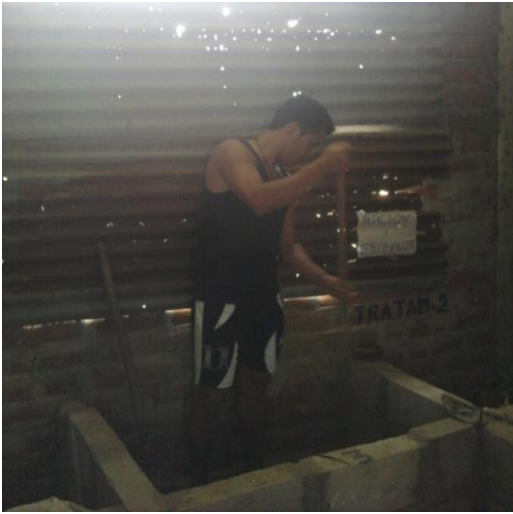
Fotografía 9. Limpieza de pozas
