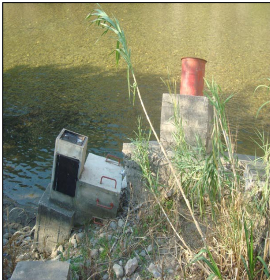
Fig. 16. Estación hidrométrica El Arenal totalmente inoperante.
