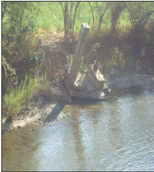
Fig. 18. Estado actual del limnigrafo y limnómetro en la estación El Arenal.
