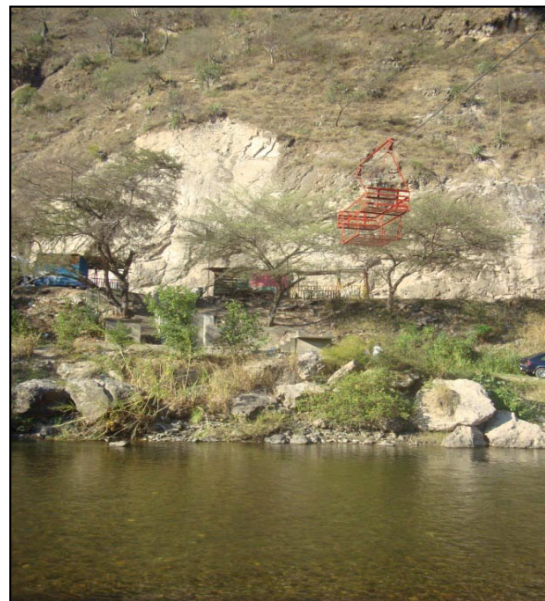
Fig. 19. Cable y carro con el que cuenta actualmente la estación hidrométrica El Arenal.
