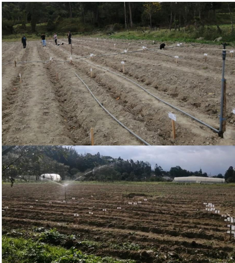
Figura 23. Instalación del sistema del riego por aspersión
