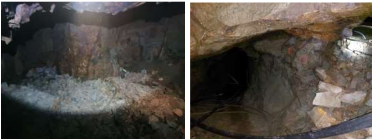
Figura 42: a. Cámara y b. pilar desgastado
