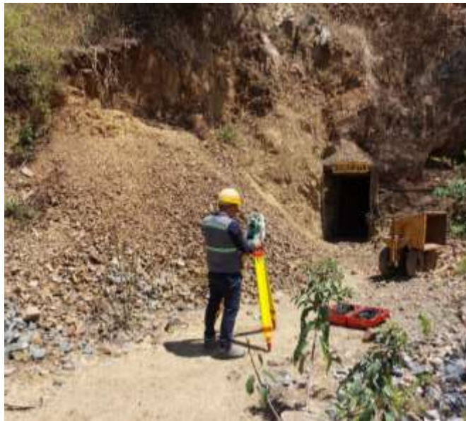
Figura 13. Arrastre de la poligonal abierta hasta la bocamina
