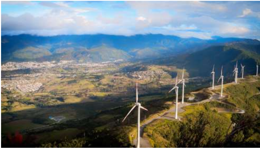
Figura 1. Central Eólica Villonaco.
