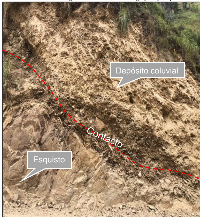
Figura 23. Contacto litológico entre la Unidad Agoyán y depósito coluvial.
