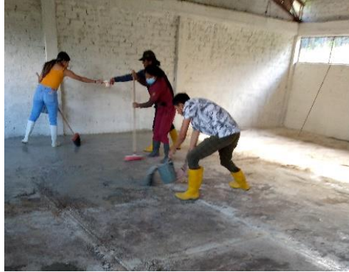
Figura 1. Adecuación de las instalaciones.
