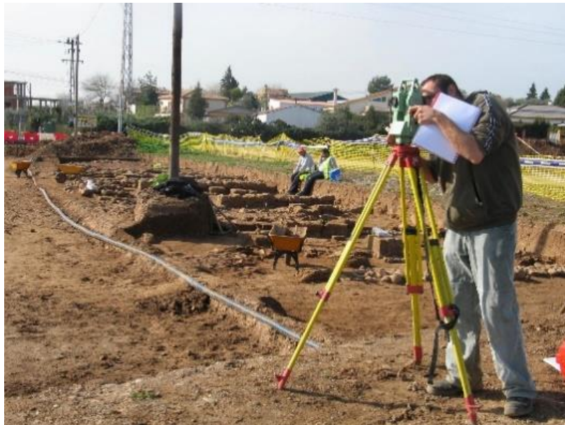
Figura 1. Levantamiento Topográfico con estación total Nota. Obtenido de (Nuñez, 2013)
