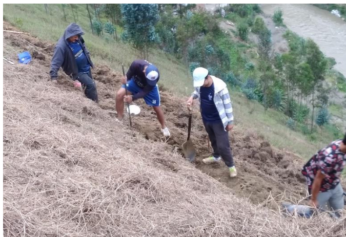
Figura 3. Construcción de Terrazas.
