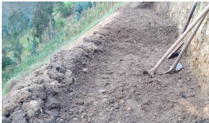
Figura 4. Aplicación de capa Arable y muro.
