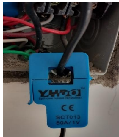
Figura 49. Montaje de los cables en los sensores
