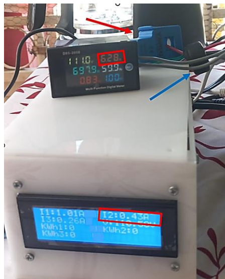
Figura 37. Pruebas del sensor de corriente de 50 A, antes de calibración.
