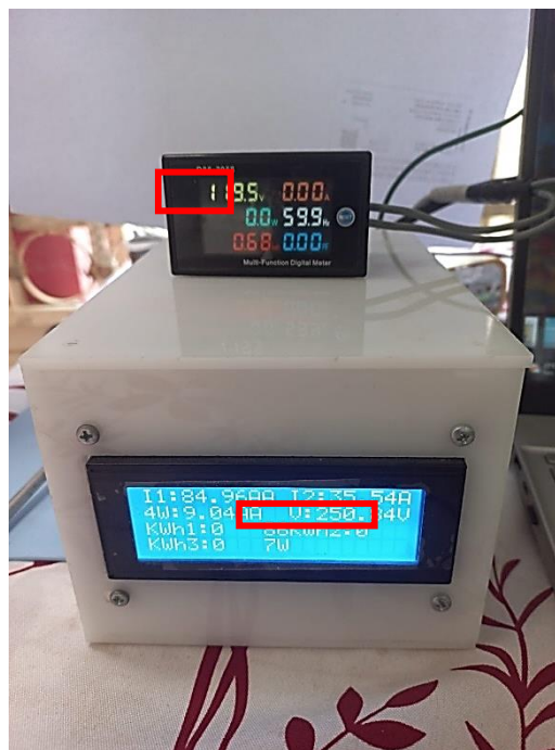
Figura 34. Pruebas de lecturas del sensor de voltaje antes de calibración.
