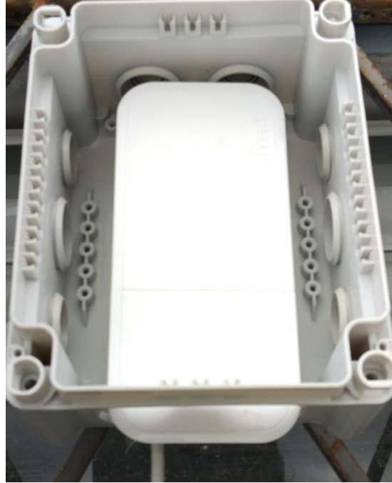
Registro Fotográfico – Gateway – instalación de Gateway LoRaWAN
