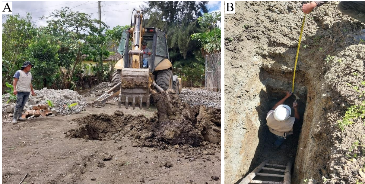
Figura 33. A) Excavación de calicatas; B) Levantamiento de información de las calicatas Nota. Elaborado por el autor, 2024
