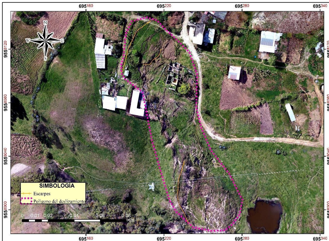
Figura 57. Deslizamiento rotacional, caracterizado en el área de interés
