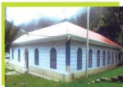
Bloque de Geología Ambiental y Ordenamiento Territorial. Reconstrucción del bloque administrativo.
