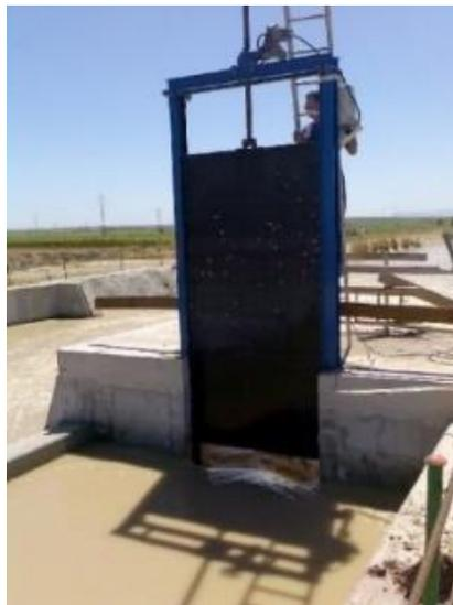
Figura 33. Compuerta hidráulica tipo canal. INAGEN ( 2018)
