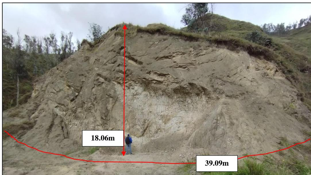
**Figura 106.** Talud de roca N°4 formado por Granodiorita.
