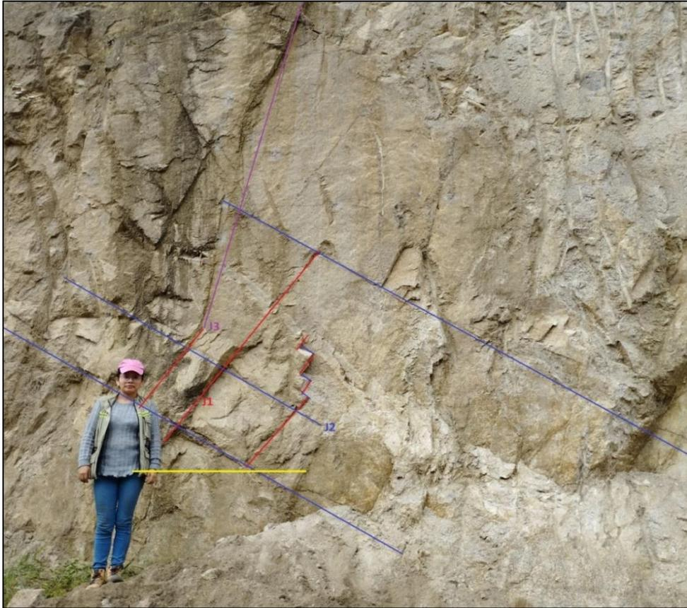
**Figura 107.** Representación gráfica de juntas en el talud de roca N°4.
