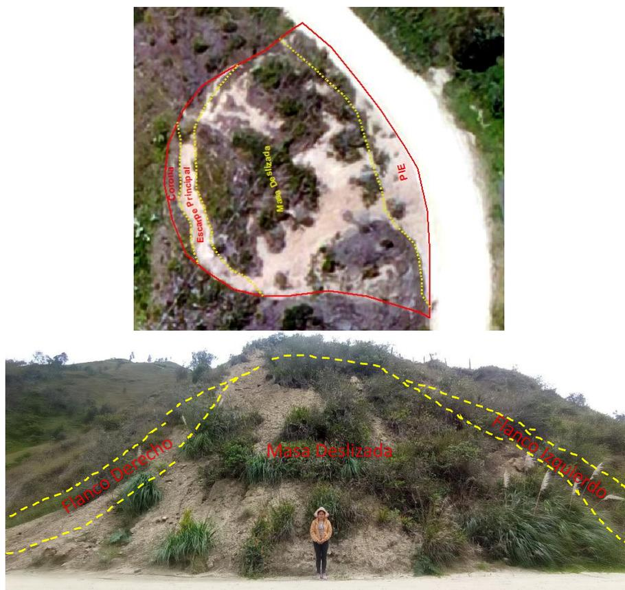
**Figura 81.** Deslizamiento MM7 formado por Esquistos micáceos.
