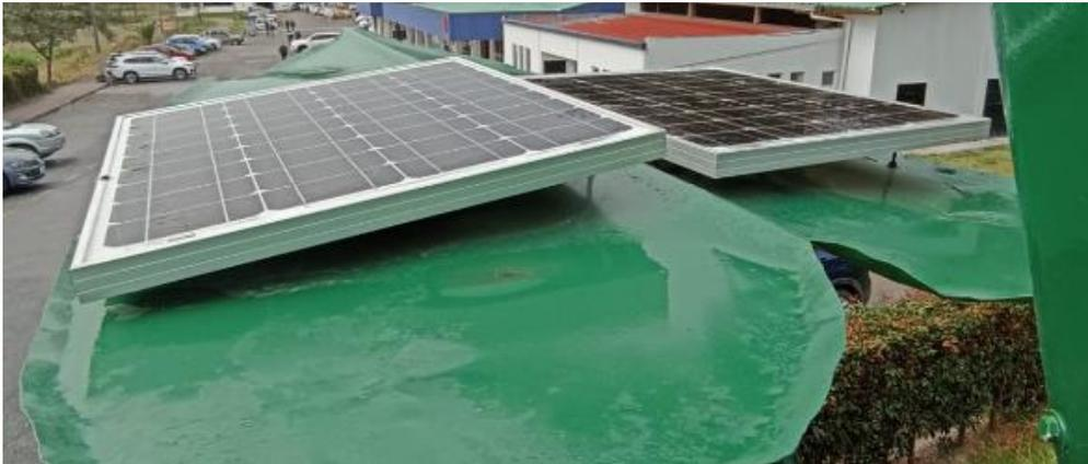
Nota. En la imagen se observa la inclinación en los paneles que corresponde a  $7^\circ$  al panel izquierdo y de  $0^\circ$  el panel de la derecha.
