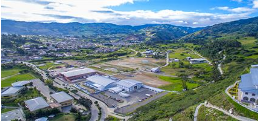
Figura 37 Vista panorámica del Parque Industrial
