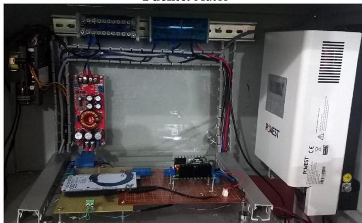
**Figura 37.** Instalación de cableado, bornes de distribución y controlador de carga solar.
