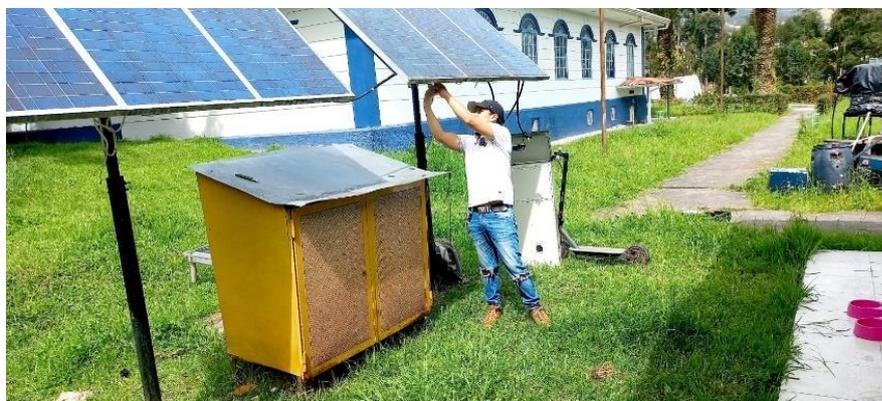
**Figura 42.** Conexión en paralelo del grupo fotovoltaico.
