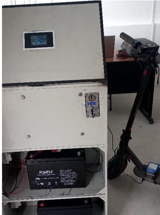
**Figura 41.** Scooter conectado a la estación recargando su batería.
