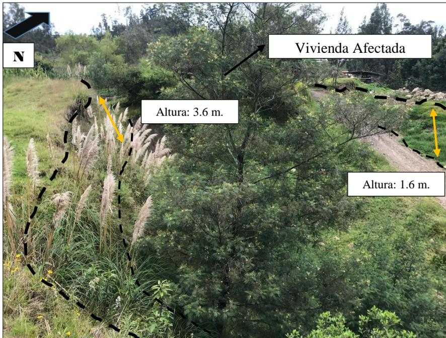
**Figura 82.** Vivienda afectada por el hundimiento #2
