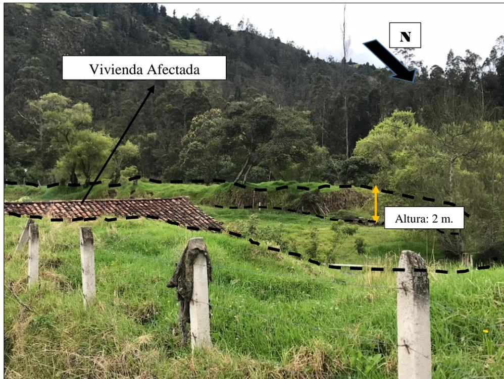
**Figura 78.** Vivienda afectada por el hundimiento #1
