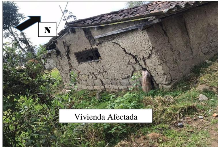
En la figura 79 se muestra un hundimiento ubicado en las coordenadas X: 696582 y Y: 9598562, con una superficie total aproximada de 0.18 ha y un desnivel de 3.6m la más alta y con 1.6m la más baja, existe una vivienda afectada por el mismo como se muestra en la figura 82 que actualmente se encuentra habitada, pero con presencia de agrietamientos.
