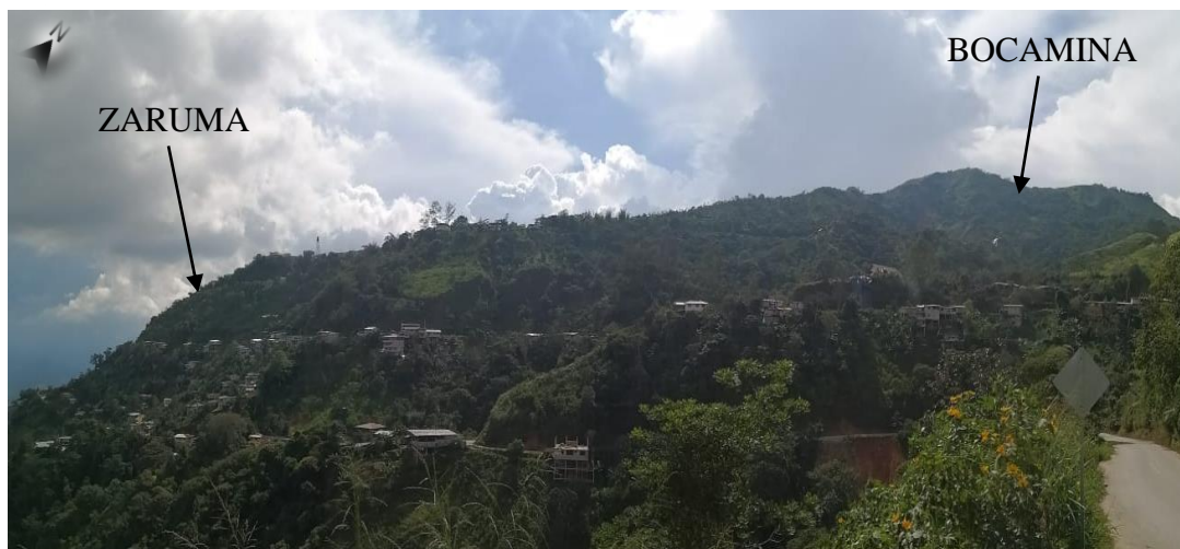
Fotografía 4. Vista general de geomorfología del cantón Zaruma y la BOCAMINA de la mina "Montesdeoca".
