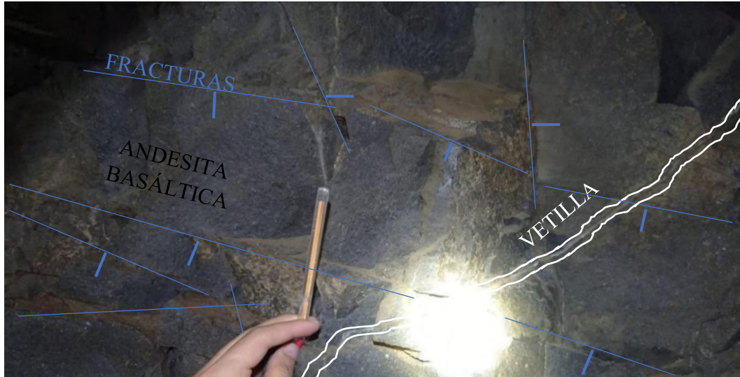
Fotografía 16. Andesita basáltica identificada en el tramo P19, sector fracturado.
