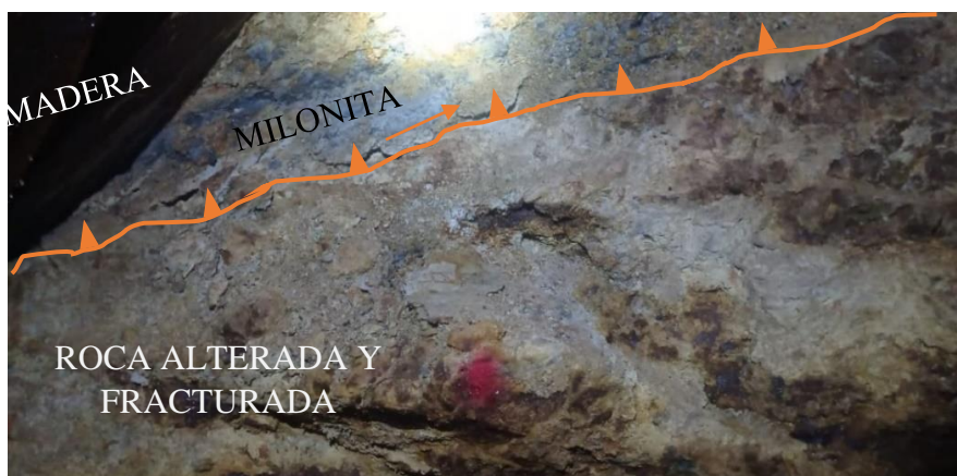
Fotografía 7. Falla en el punto P8, sostenimiento de madera y presencia de milonita.
