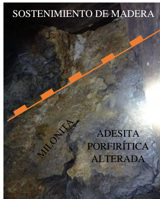
Fotografía 9. Falla normal de 0.5 m de salto de falla, con sostenimiento de madera.
