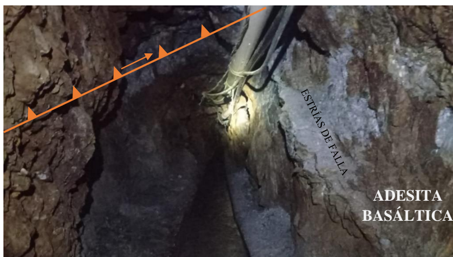
Fotografía 10. Falla en baipás (P11A3), presencia de milonita y filtración de agua.
