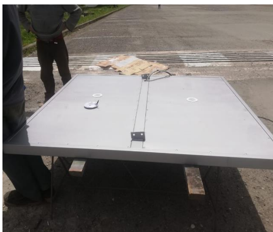
b) Verificación de instalación de luminarias y sensor de movimiento
