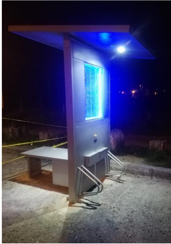
b) Instalación total de la infraestructura en la noche
