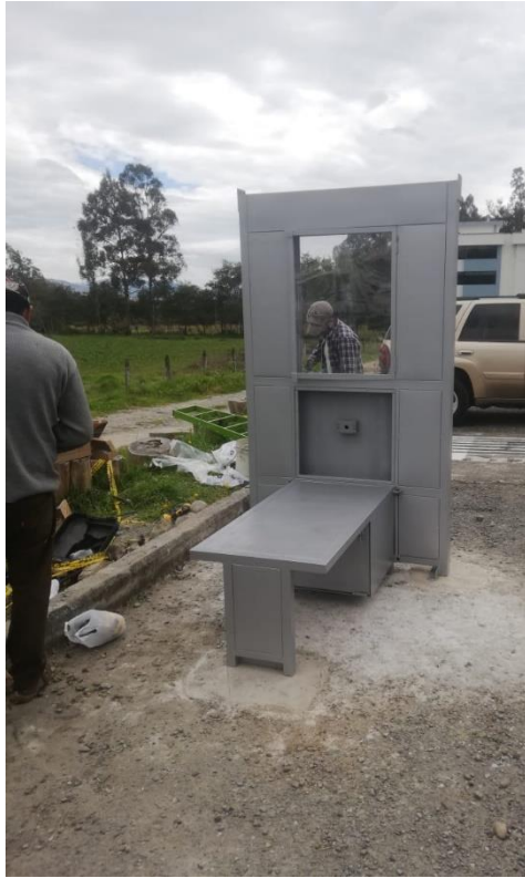
c) Instalación de soporte y caja de equipos en la base principal
