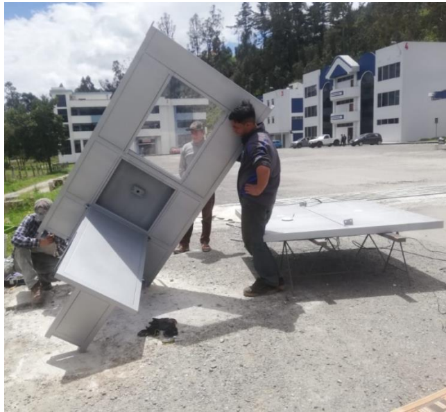
d) Instalación de cuerpo de panel solar y caja de equipos en la base
