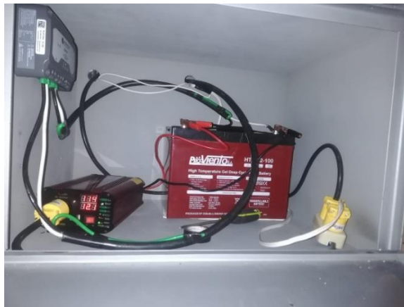
b) Instalación de equipos electrónicos
