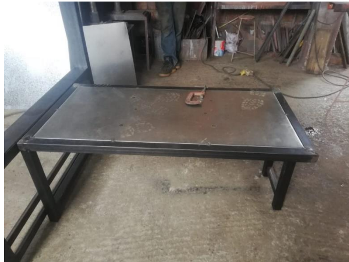
c) Soporte y caja de equipos de la estación solar en construcción.
