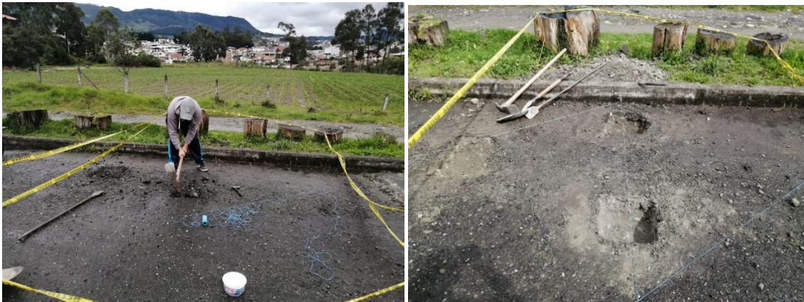
b) Cavado del suelo para realizar las bases de la infraestructura
