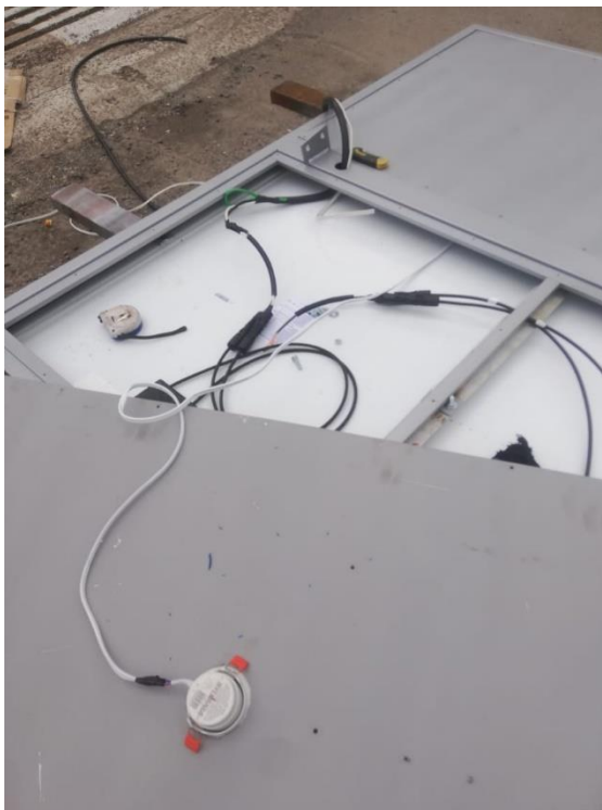
a) Instalación de lámparas eléctricas
