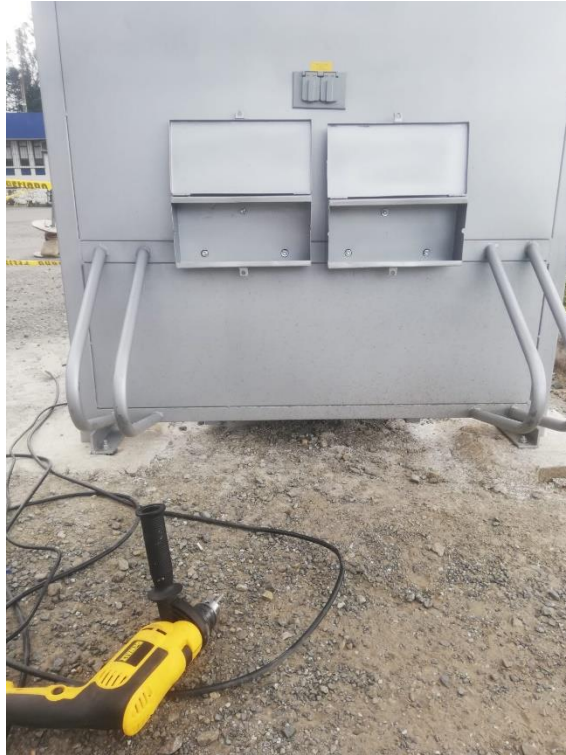
e) Instalación de cajas para cargadores de vehículos eléctricos de baja potencia
