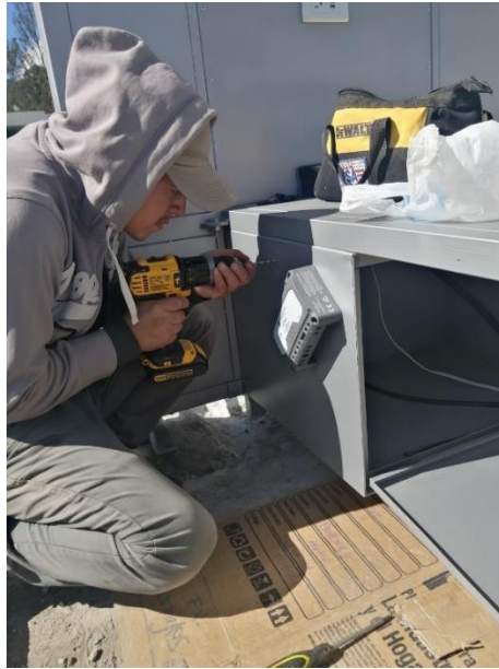
a) Medición y perforación para pernos de los equipos eléctricos
