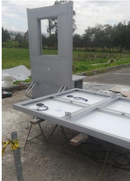
a) Instalación de paneles solares en el soporte
