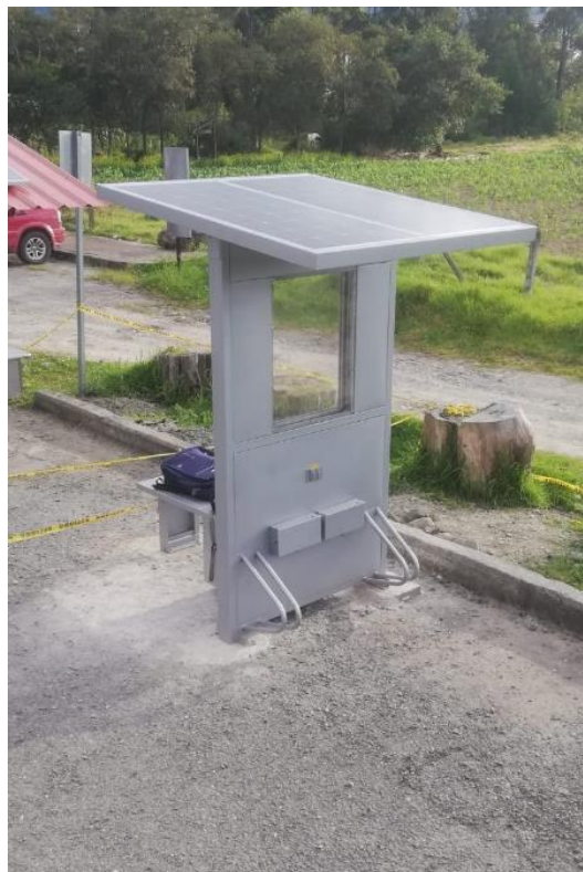
a) Instalación total de la infraestructura en el día.
