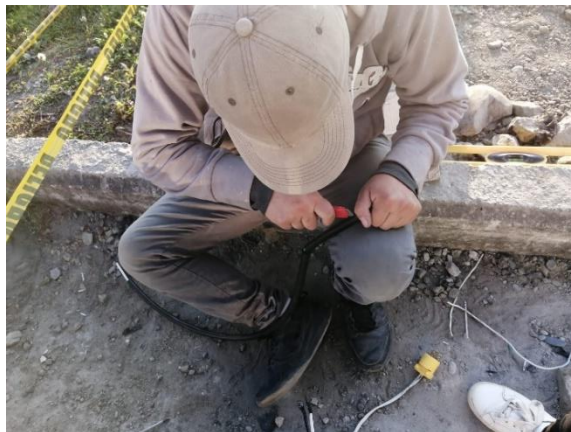
c) Empalme de cables para conexiones eléctricas
