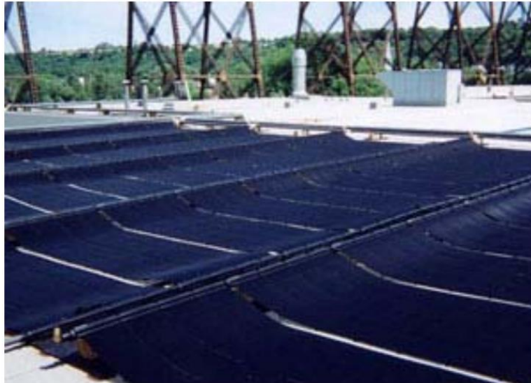
Figura 7. Foto de un colector de placa plana sin cubierta.
