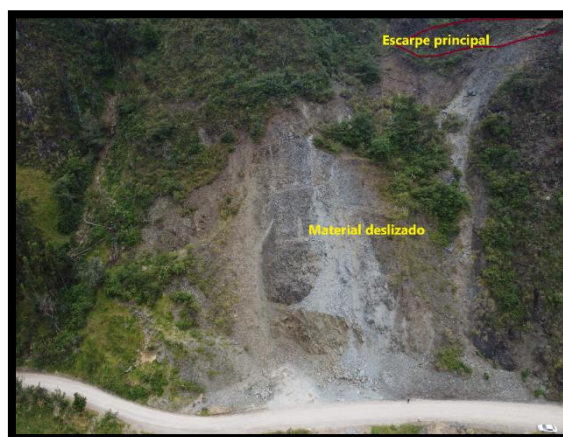
Figura 83. Deslizamiento 9. x: 748410,174; y: 9665693,575; z: 2595,52
