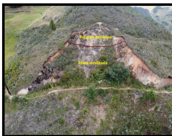
Figura 81. Deslizamiento 7. x: 746961,531; y: 9662951,975; z:2863,5
