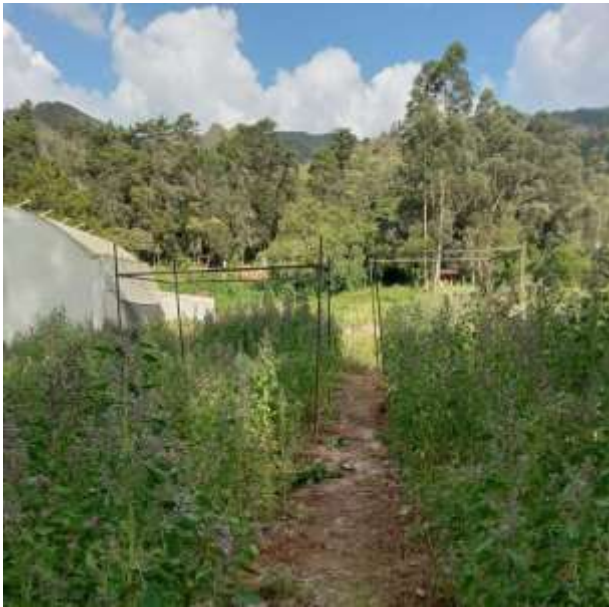
Figura 21: Colocación de los parantes para la sombra
