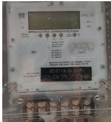
Figura 14. Medidor marca Star Clase 100, 13A.
