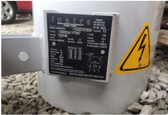
Figura 11. Transformador monofásico de 15kVA.
