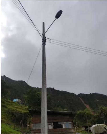
Figura 5. Poste de HC (hormigón armado circular) de 12m en baja tensión.
