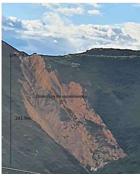
Figura 52: Deslizamiento rotacional, sector las Chinchas.
