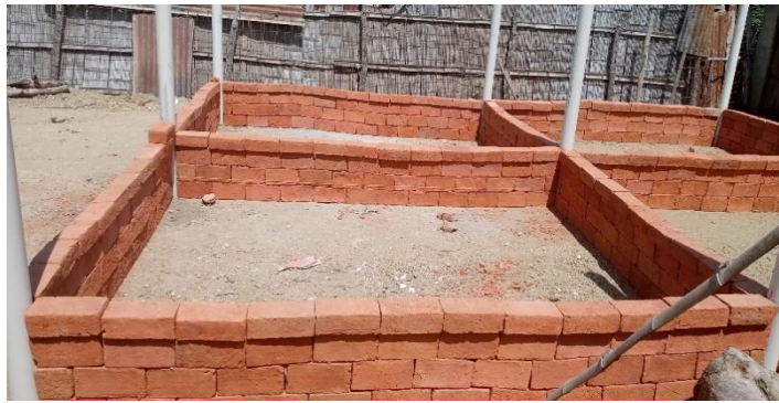
Imagen 1. Construcción del galpón
