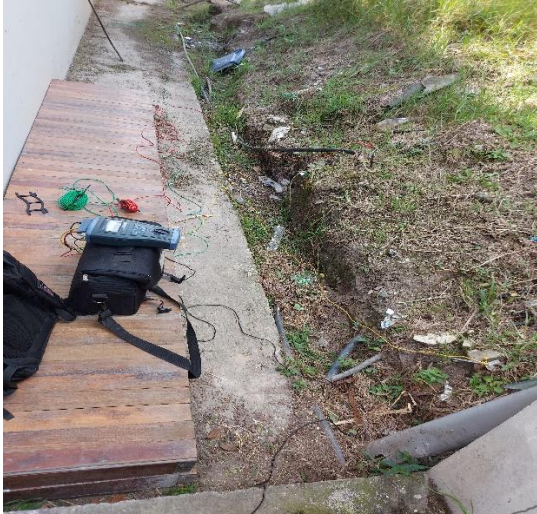
Figura A. 25: Medición de resistividad del sistema de tierra del bloque A9. Fuente: Compilada por el Autor.
