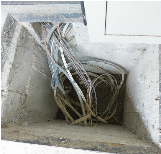
Figura A. 17: Pozo de revisión interno del Bloque A6 convergencia de las diferentes conexiones del Bloque A2. Fuente: Compilada por el autor.
