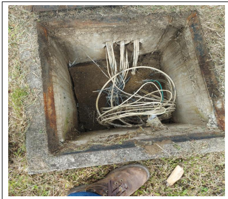
Figura 32. Pozo de revisión entre el Bloque los A2 (laboratorios) y A6 (Cuarto de máquinas).
