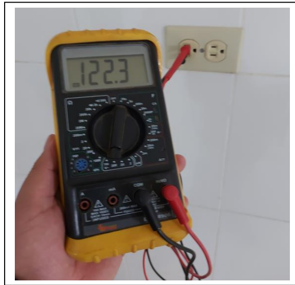
Figura 19: Medida de valores de tensión en tomacorrientes de la FEIRNNR.
