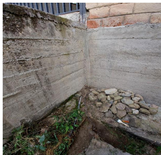
Figura A. 24: Puesta a tierra identificada al ingreso del bloque A25.
