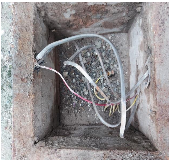
Figura A. 21: Puesta a tierra identificada en el pozo de revisión junto al bloque A9.
