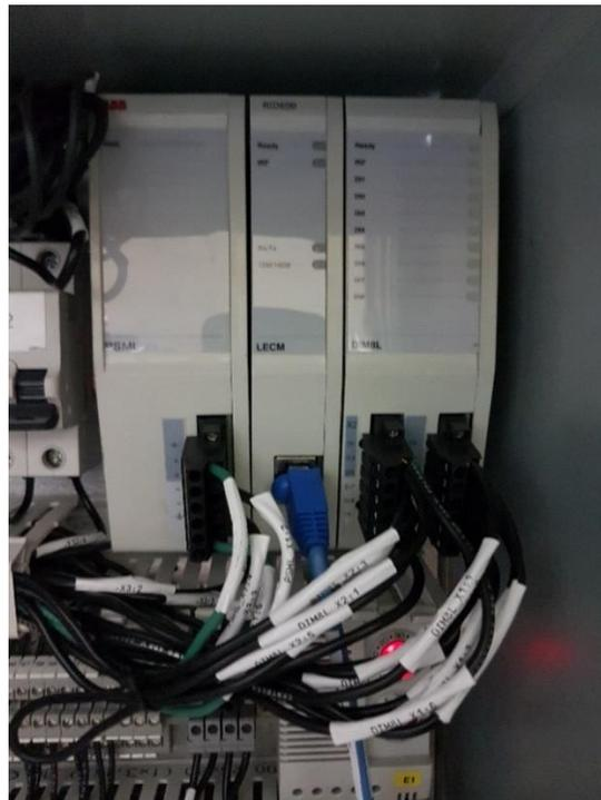
**Figura 31:** Módulo RIO600 ubicado en cámara de transformación.
