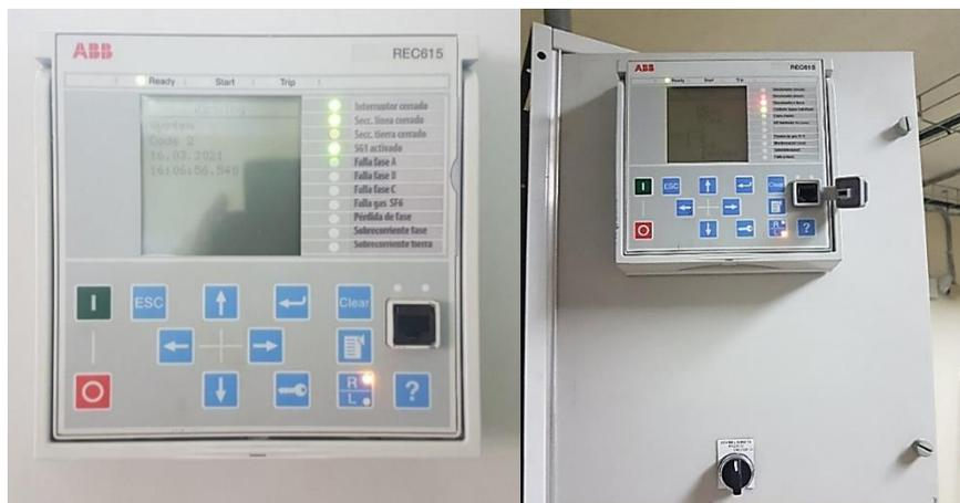
**Figura 28:** Relé REC615 en cámara de transformación.
