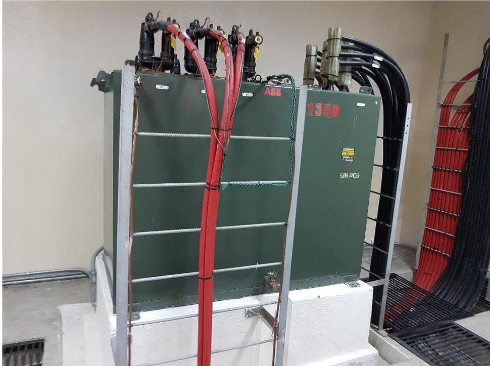
**Figura 23:** Transformador trifásico de 500kVA instalado en cámara de transformación.
