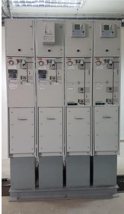
**Figura 25:** Celdas de medio voltaje tipo CCVV SafePlus de ABB.
