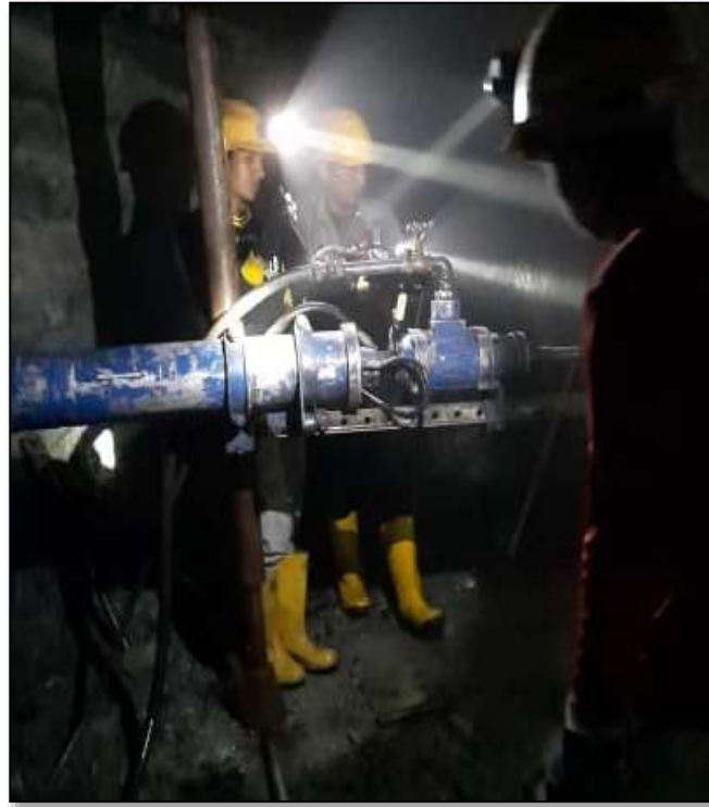
Figura 46. Equipo de perforación
