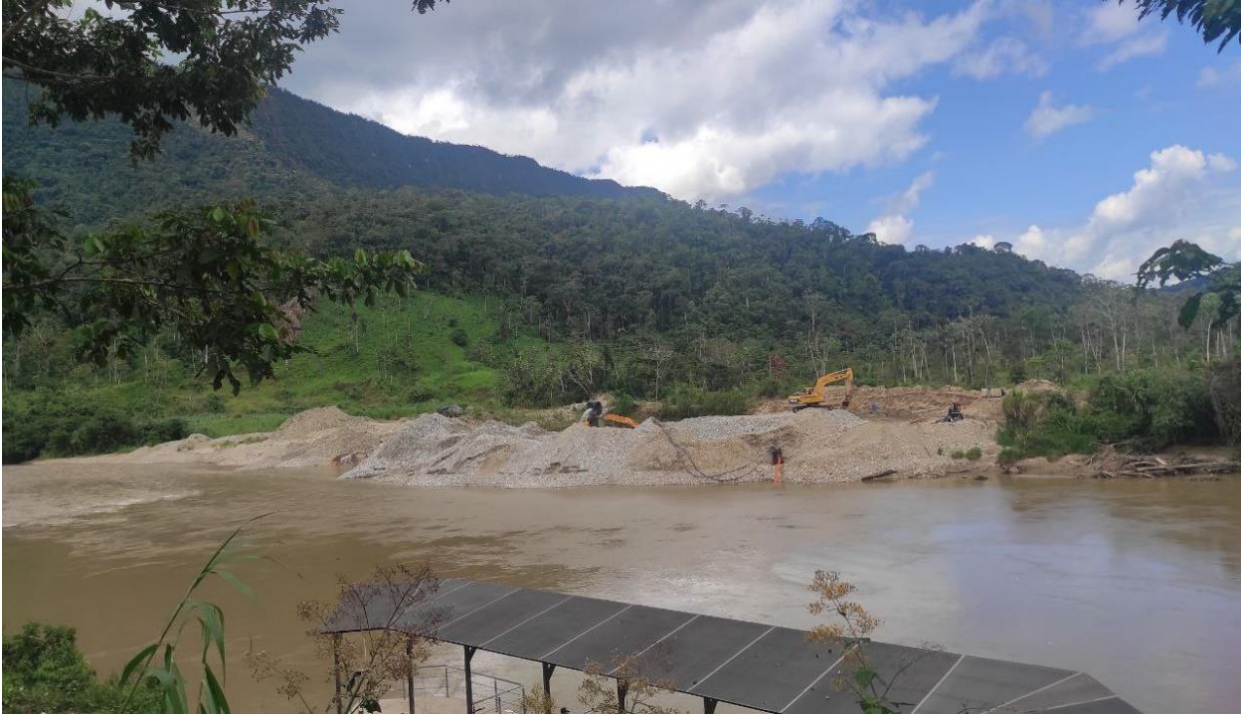
Foto 6. Alteración del cauce natural del Río Nangaritza con fines extractivos.
