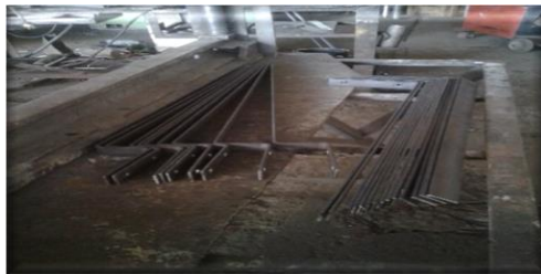
Figura 31: Doblado de las varillas. Fuente: Propio.
