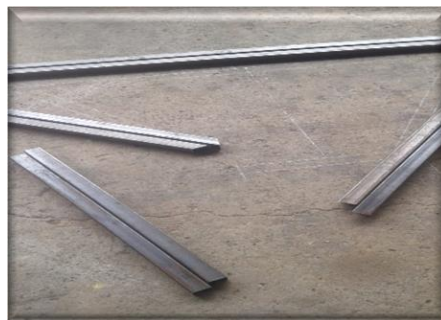
Figura 28: Corte de los tubos. Fuente: Propio.
