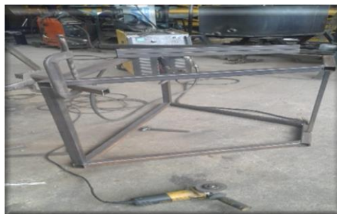
Figura 29: Montaje de la estructura. Fuente: Propio
