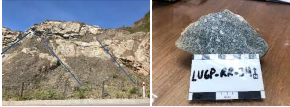
Figura. 38: Intrusivo granitoide de composición diorítica, expuesto en la vía Paccha Buenavista, sector Dauca.
