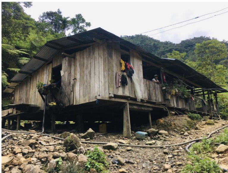
Fotografía. 23 Vivienda del barrio Los Laureles.
