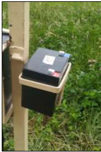
Ilustración 18. Montaje de la Batería
