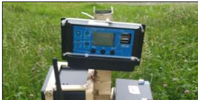
Ilustración 20. Montaje del Controlador de Carga Solar
