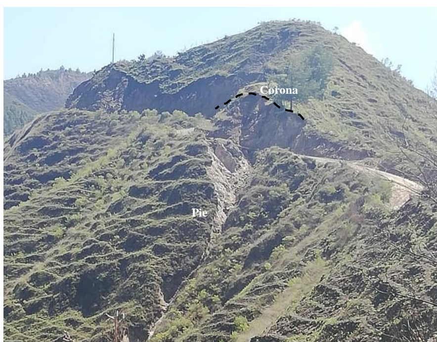
Figura 36: Deslizamiento 20, sector La Palma
