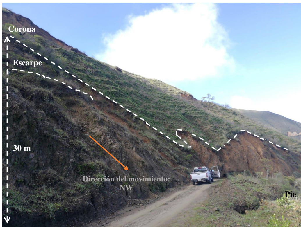
Figura 35: Deslizamiento 7, sector de Huacabamba
