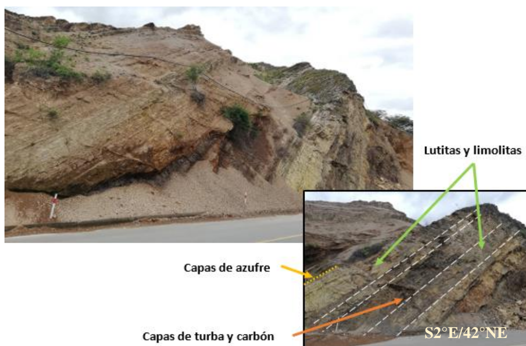
Figura 25: Intercalaciones de lutitas, areniscas y carbón, presencia de pátinas de azufre. (UTM: 689160E; 9540892N)
