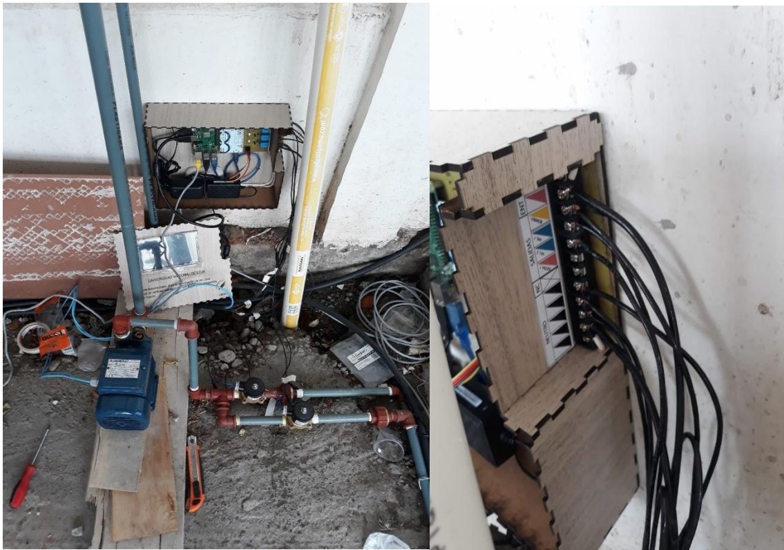
Figura 66 instalación de tablero de control
