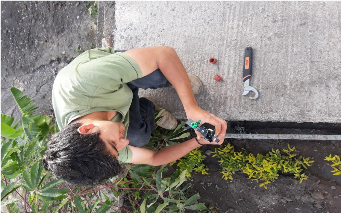
Figura 67 instalación de Aspersor
