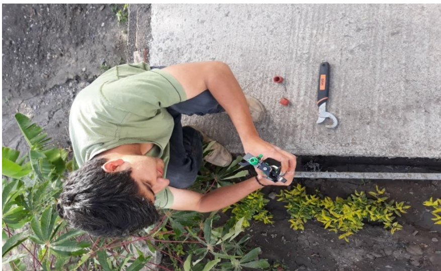
Figura 39 instalación de aspersores.
