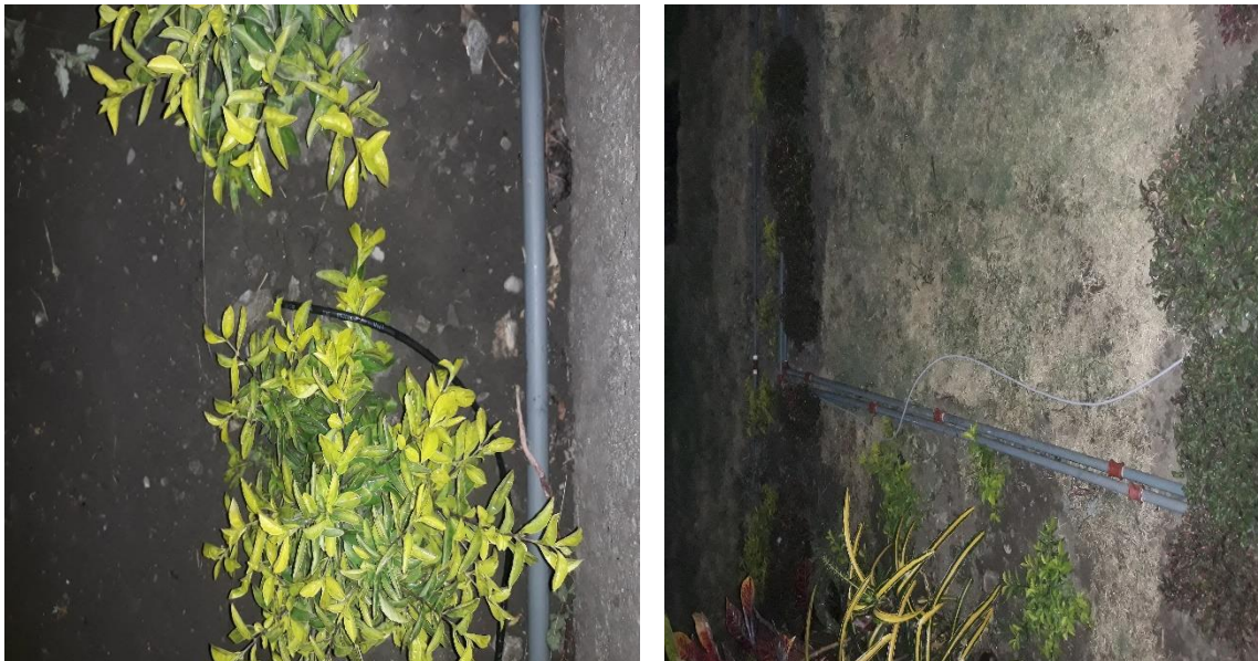
Figura 41 Soterramiento de Sensores de humedad
