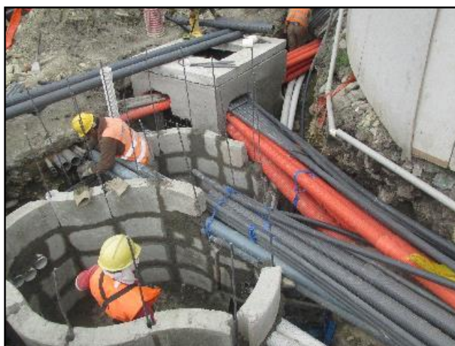
Figura 53. Disposición de pozo eléctrico en forma cuadrada.
