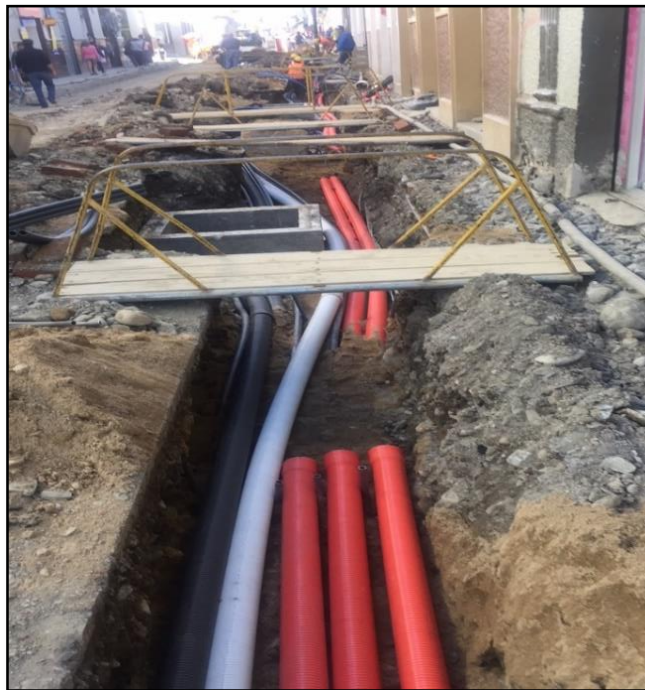
Figura 50. Disposición de ductos en canalización bajo acera.
