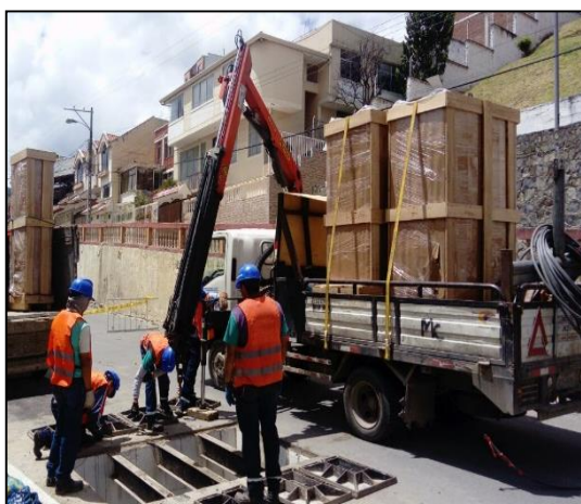
Figura 58. Acceso hacia el interior de las C.T. para el ingreso o extracción de equipos eléctricos.
