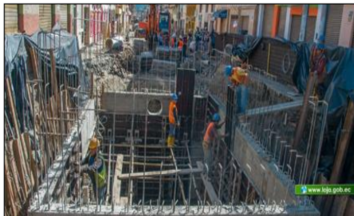
Figura 47. Hormigón armado para la pared de la C.T. 16.
