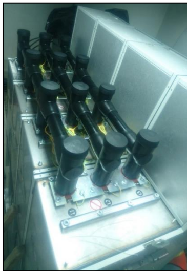
Figura 84. Embarrado de Celdas SafePlus.
