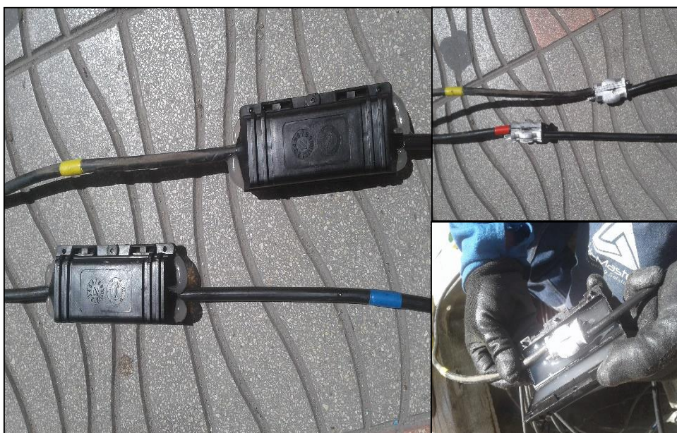
Figura 122. Empalme tipo Gel para alumbrado público.
