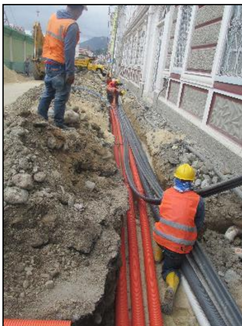
Figura 49. Colocación de ductos en las canalizaciones.
