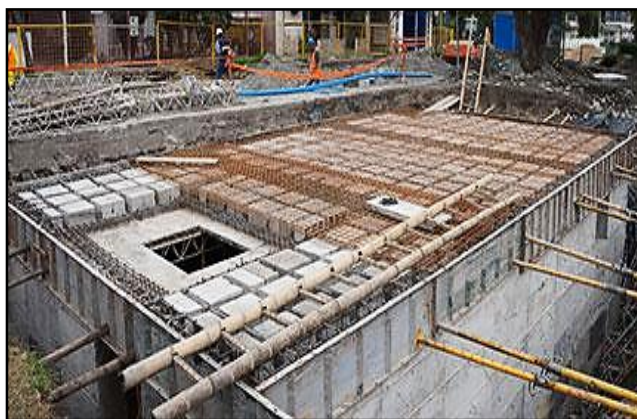
Figura 46. Hormigón armado para las losas de las cámaras eléctricas.
