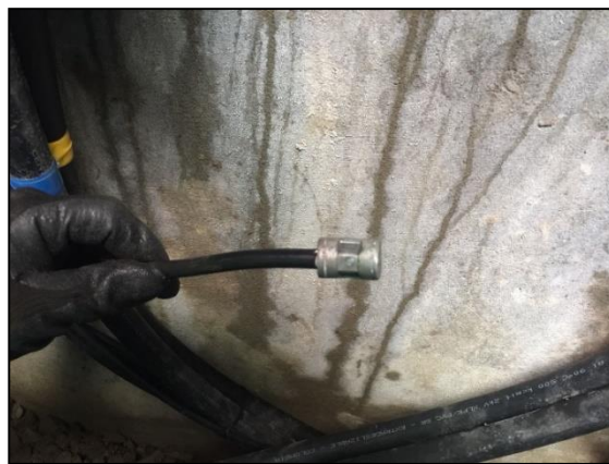
Figura 109. Terminales usados para derivaciones de acometidas domiciliarias.
