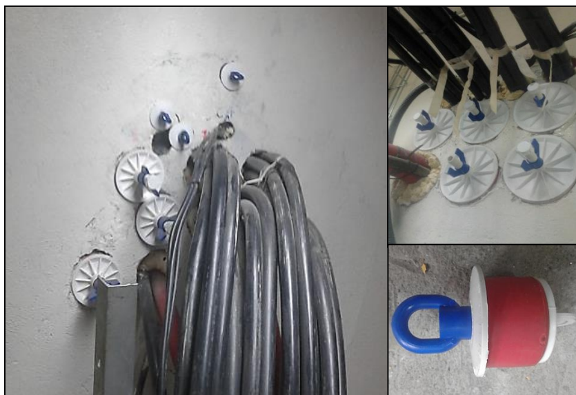
Figura 48. Taponamiento de ductos.
