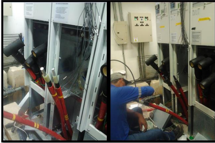
Figura 72. Procedimiento de conexión del cable conductor de M.T. en las celdas.
