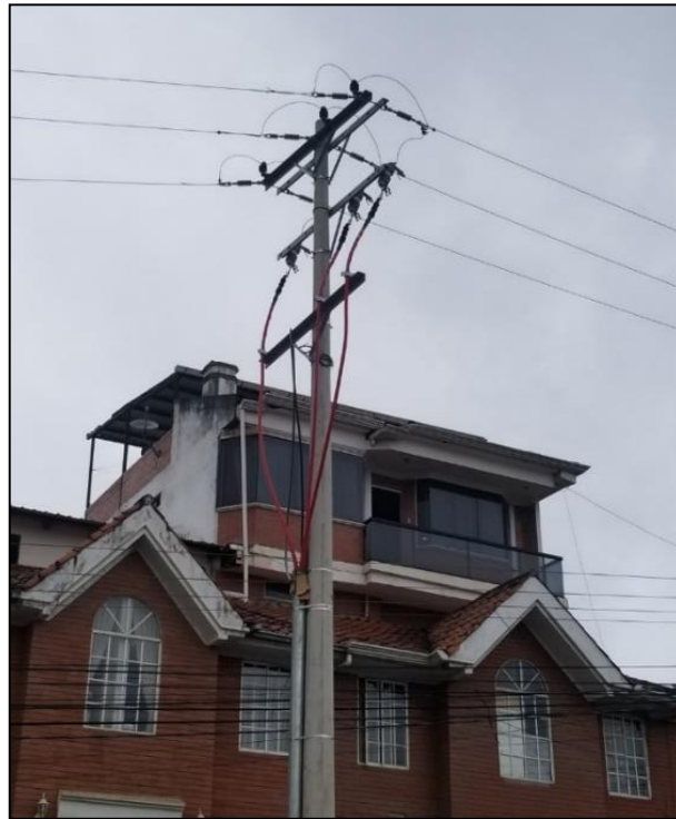
Figura 67. Transición subterránea – aérea.
