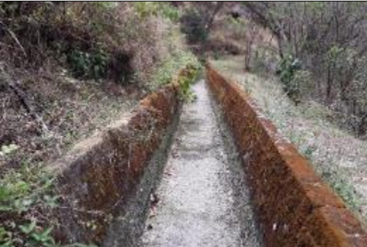
Fotografía N° 8. Levantamiento técnico para el análisis del estado actual del tramo II.
