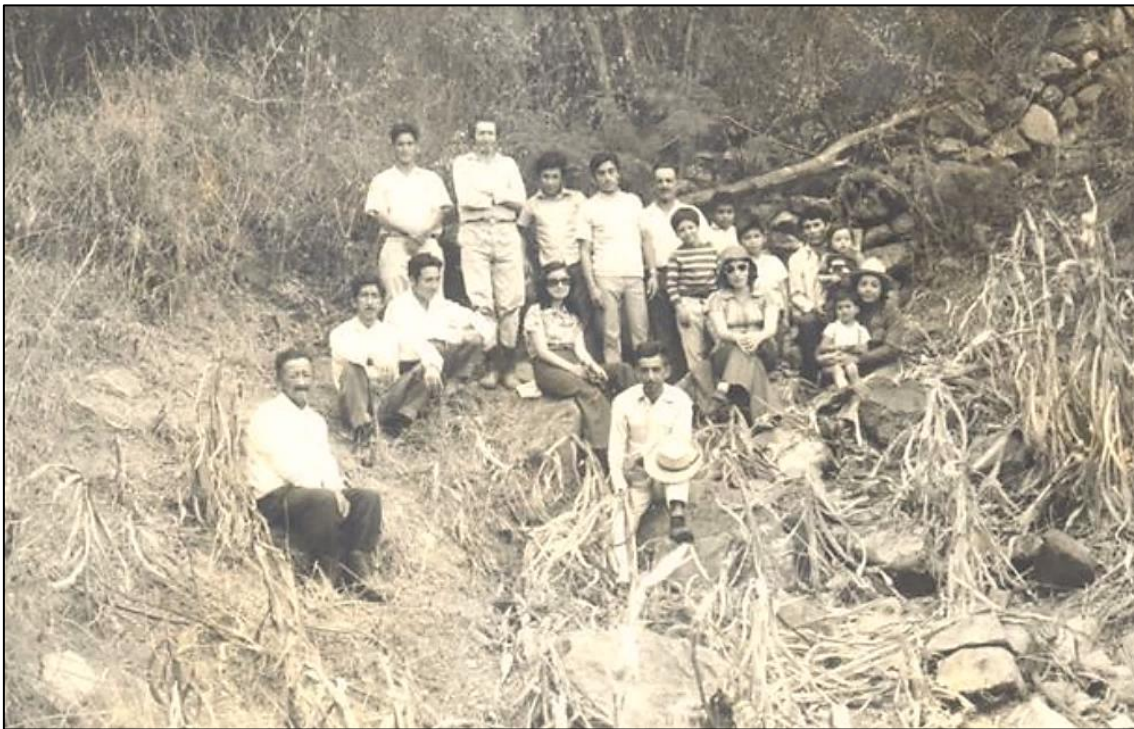
Fotografía 28. Habitantes de la parroquia en la construcción del canal alto. Fuente: Segundo Erazo, 1952.
