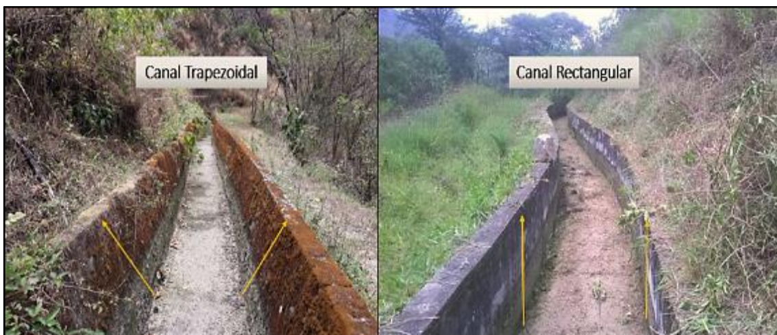
Fotografía 33. Construcción mixta del Canal Alto. Fuente. La Autora, 2019.
