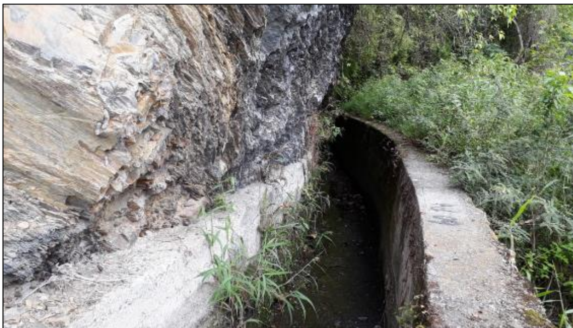
Fotografía 70. Canal completo en la sección N° 13. Fuente. La Autora, 2019.
