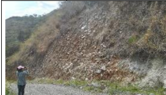
Fotografía N° 5. Levantamiento de afloramientos a lo largo del tramo II.
