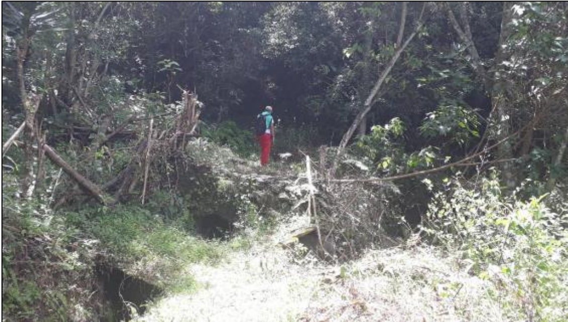
Fotografía 67. Túnel de hormigón armado sección N° 10 perteneciente al tramo II.
