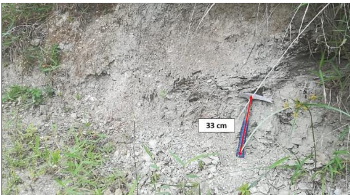
Fotografía 40. Depósito coluvial con matriz arcillosa del tramo II. Fuente. La Autora, 2019.
