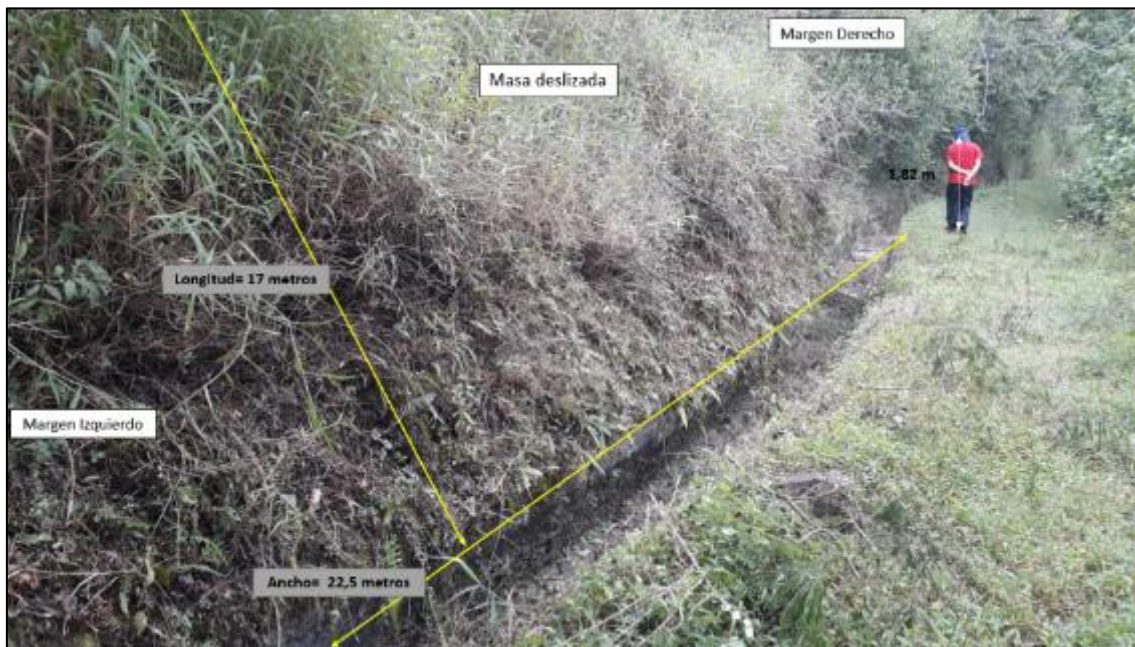
Fotografía 45. Deslizamiento N° 4 del tramo II. Fuente. La Autora, 2019.
