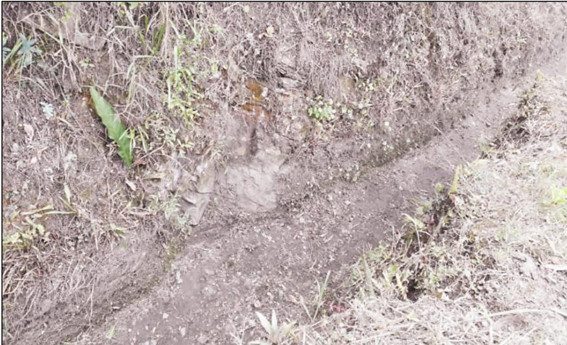
Fotografía 60. Canal de roca y tierra sección N°3. Fuente. La Autora, 2019.
