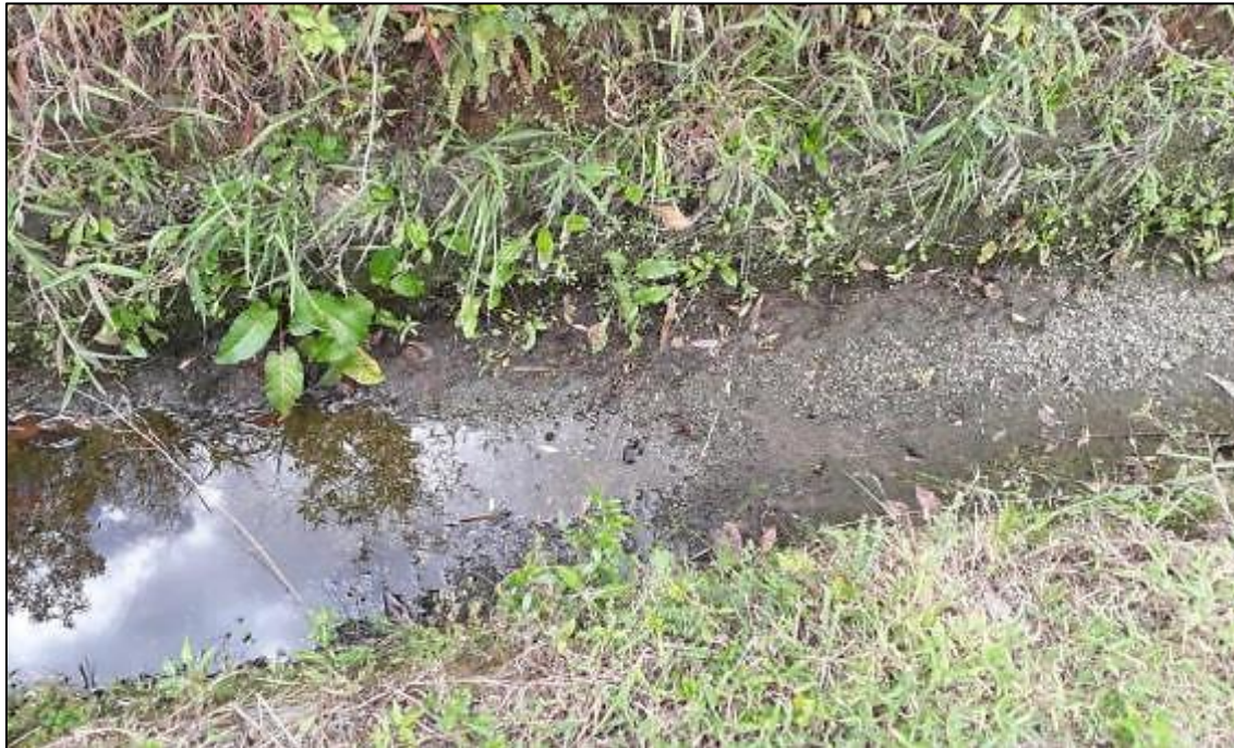
Fotografía 62. Canal completo sección N°4, perteneciente al tramo II. Fuente. La Autora, 2019.
