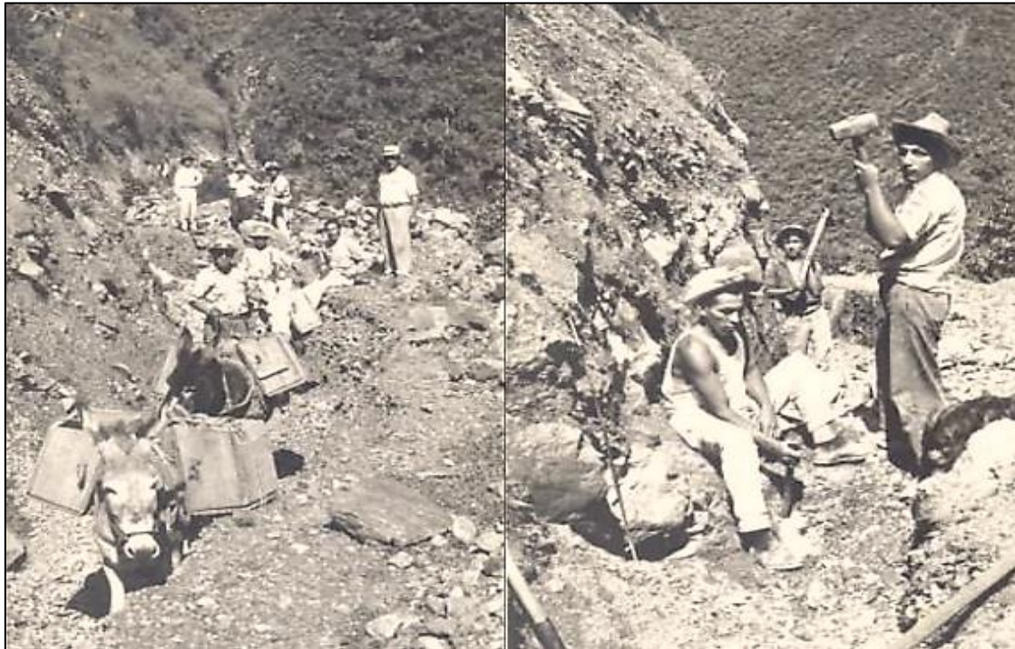
Fotografía 29. Inicios de la construcción del canal Alto. Fuente. Segundo Erazo, 1952.
