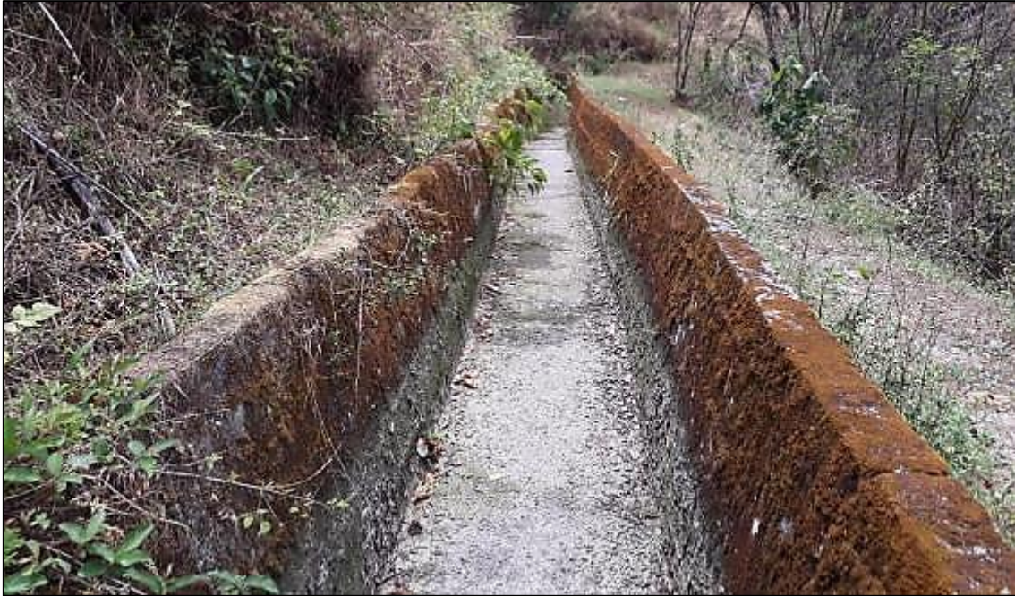
Fotografía 59. Canal completo sección N°2, perteneciente al tramo II. Fuente. La Autora, 2019.
