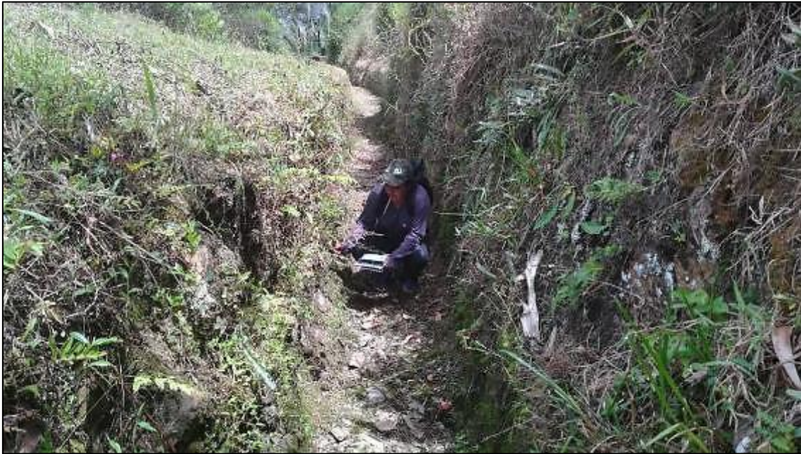
Fotografía 65. Canal de roca y tierra sección N°8. Fuente. La Autora, 2019.
