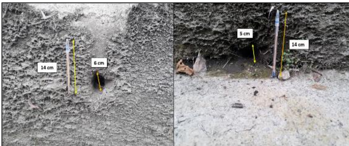
Fotografía 54. Agujeros en la pared interna del canal. Fuente. La Autora, 2019.
