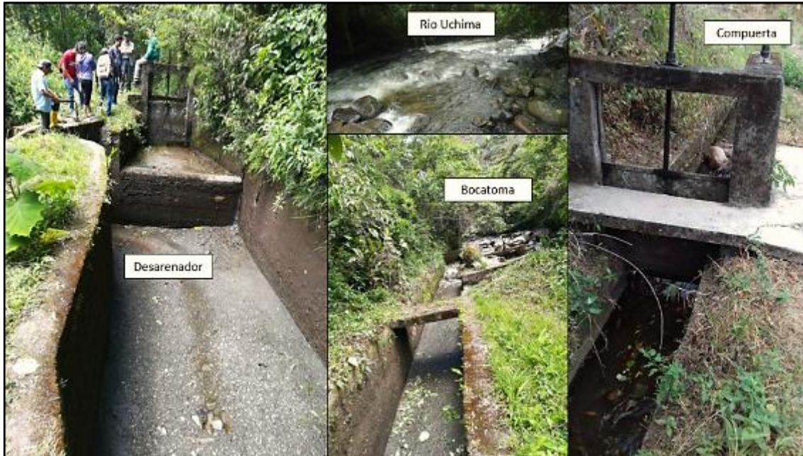
Fotografía 32. Partes hidráulicas del Canal Alto. Fuente. La Autora, 2019.
