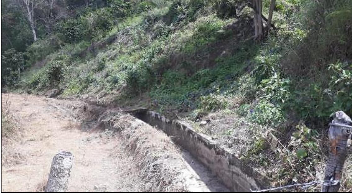
Fotografía 64. Canal completo perteneciente sección N°7. Fuente. La Autora, 2019.
