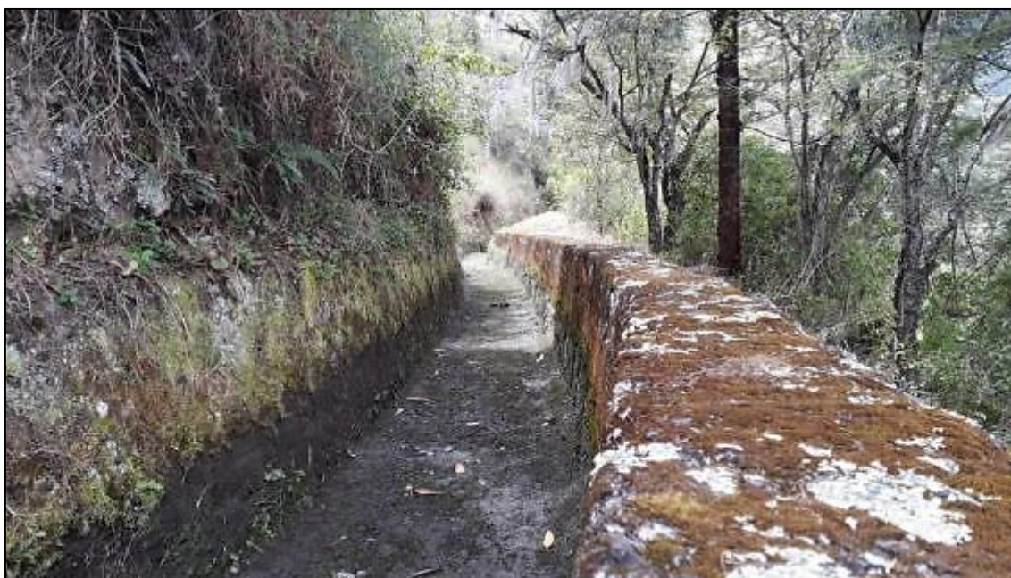
Fotografía 61. Canal completo sección N°4. Fuente. La Autora, 2019.
