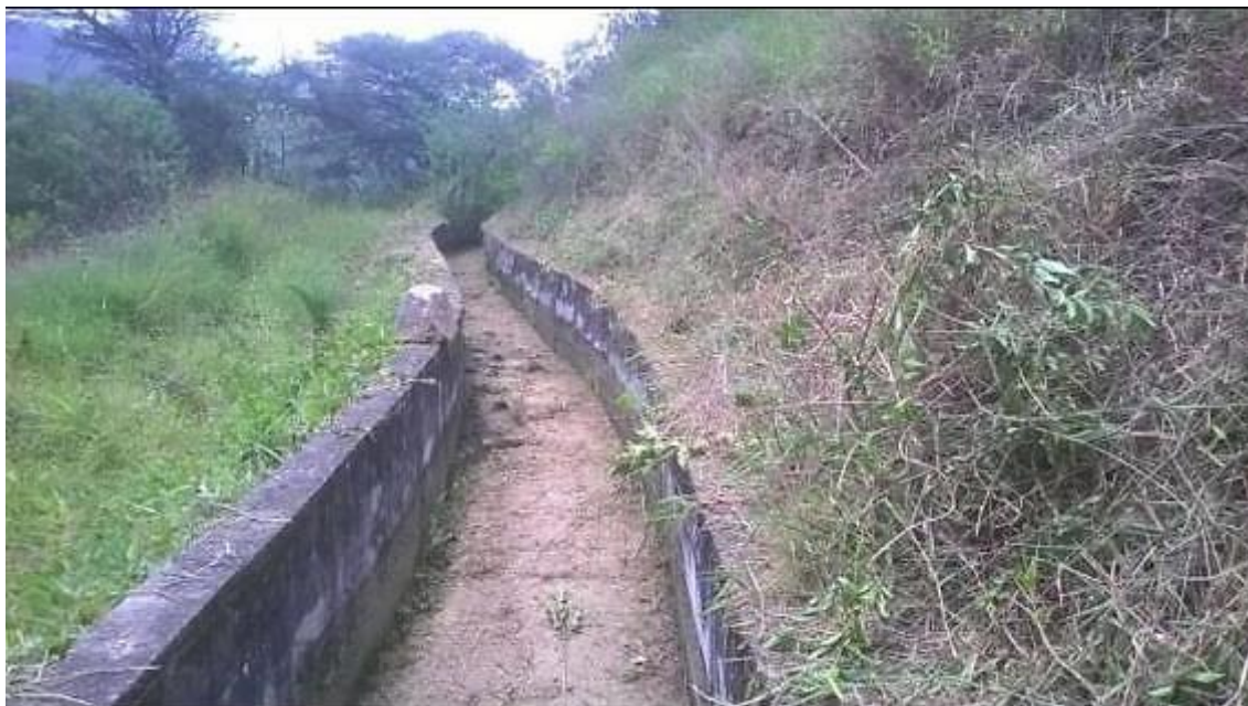
Fotografía 66. Canal completo sección N°9. Fuente. La Autora, 2019.
