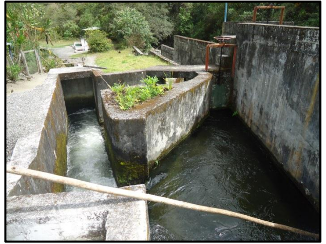
Anexo 5. Obra de captación del canal de riego
