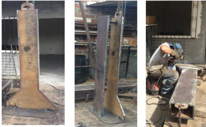
*Imagen E.5. Armado de columnas y faldón superior*
