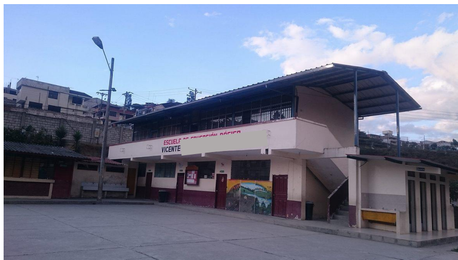
Fuente: Infraestructura de Escuela Vicente Bastidas Reinoso Autor: Fabián Ortiz Córdova
