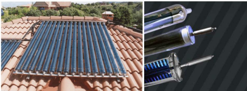
Figura 9: a) Foto Colector Solar de Tubo de Vacío Heat Pipe b) Distintos tipos de Tubos de Calor
